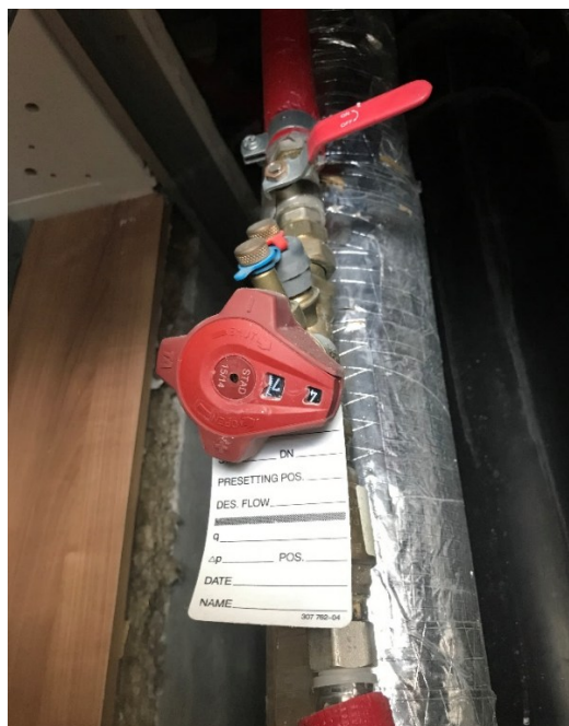
Figura 8.9 – Válvula de regulação instalada
