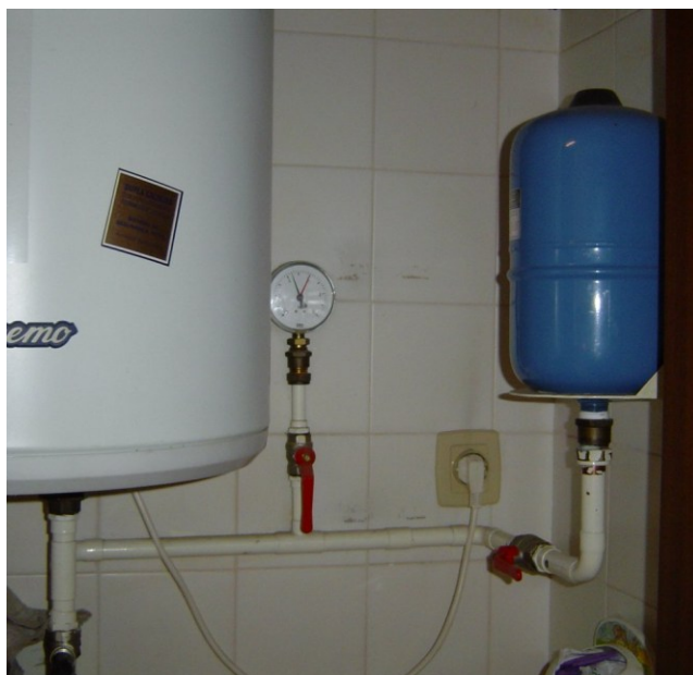
Figura 5.13 – Exemplo de montagem de um vaso de expansão
