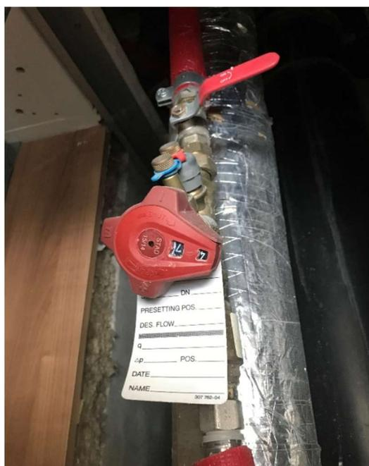
Figura 8.8 – Válvula de regulação instalada
