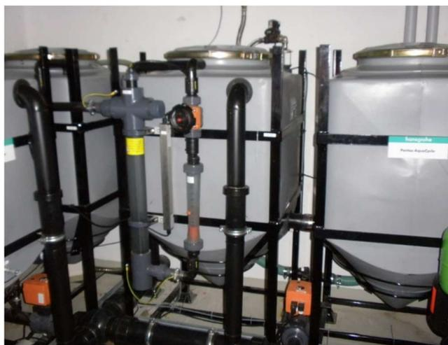
Figura 8.10 – Instalação de tratamento de águas cinzentas numa residência de estudantes
