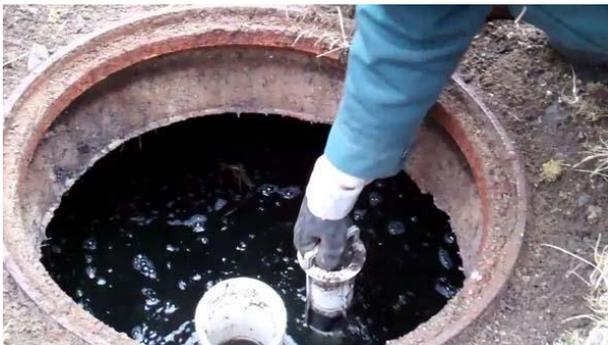
Figura 6.1 – Verificação do nível do efluente no interior de uma fossa séptica.
