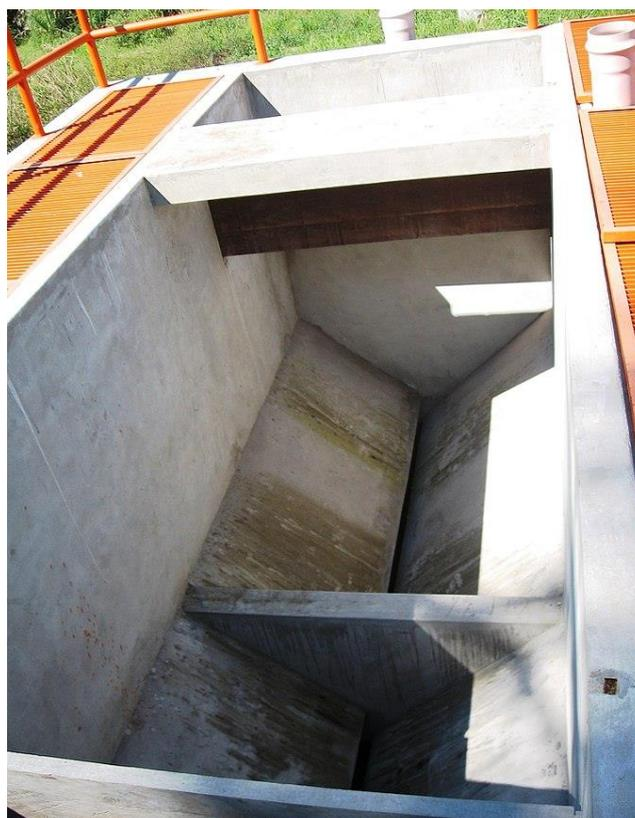
Figura 3.3 – Vista de um Tanque Imhoff
