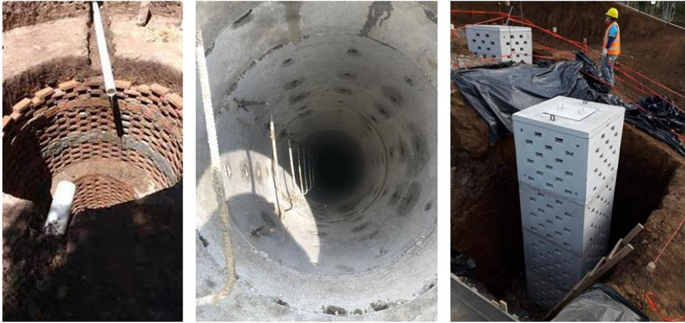
Figura 5.5 – Imagens de poços de infiltração (Grupo MT, pozosdeabsorcion)
