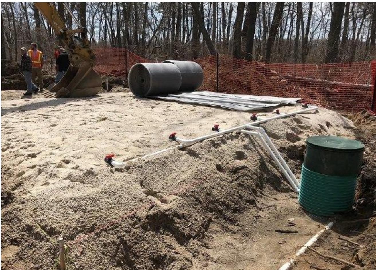
Figura 5.8 – Instalação de aterro filtrante a jusante de um sistema de tratamento compacto (Crédito: US EPA).
