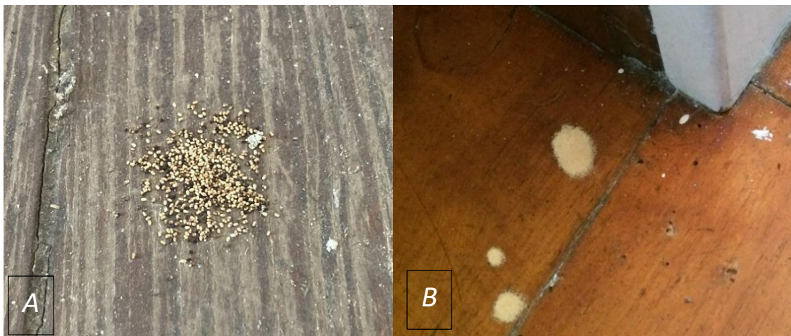
Figura 7- A: Pelotas fecais de térmitas. B: Dejetos de caruncho (Fotos: Rui Martins)
