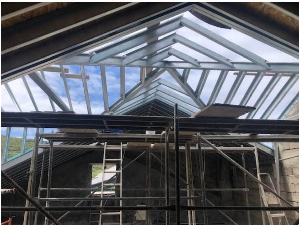
Figura 11- Estrutura metálica instalada numa moradia na Horta (Foto: João Melo)
