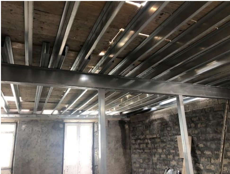
Figura 10- Estrutura metálica instalada numa moradia na Horta (Foto: João Melo)
