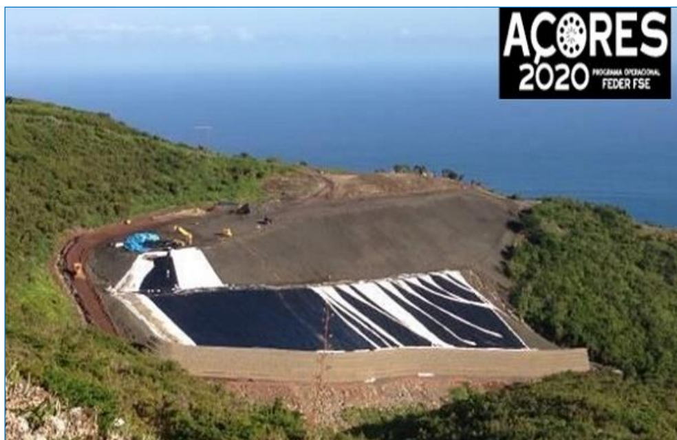
Figure 4 Sealing of Santa Cruz landfill site at Lugar das Barrosas.
