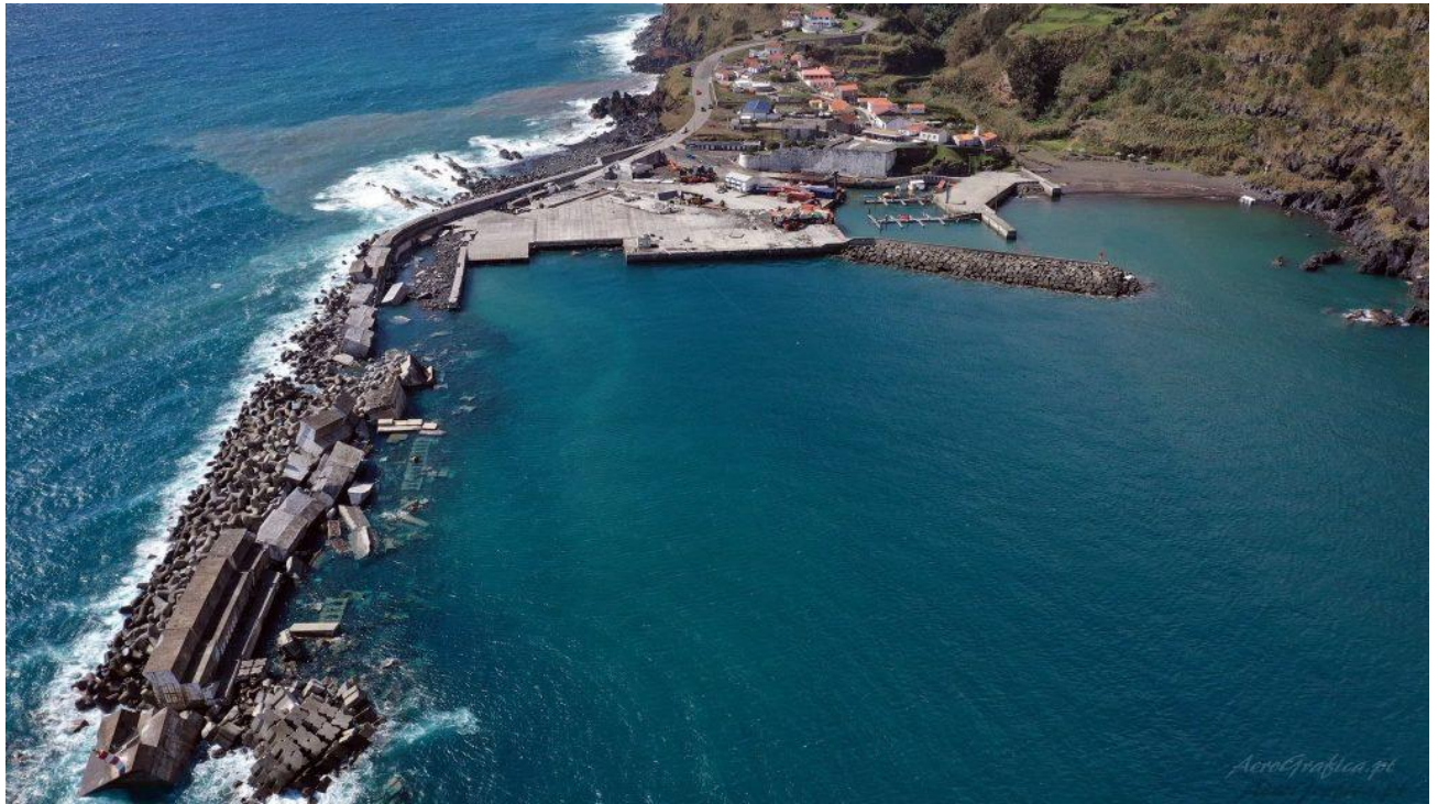
Figura 2.9.1 | Destruição do quebramar do porto comercial das Lajes das Flores pelo furacão Lorenzo, 2019. Fonte: Portos dos Açores
