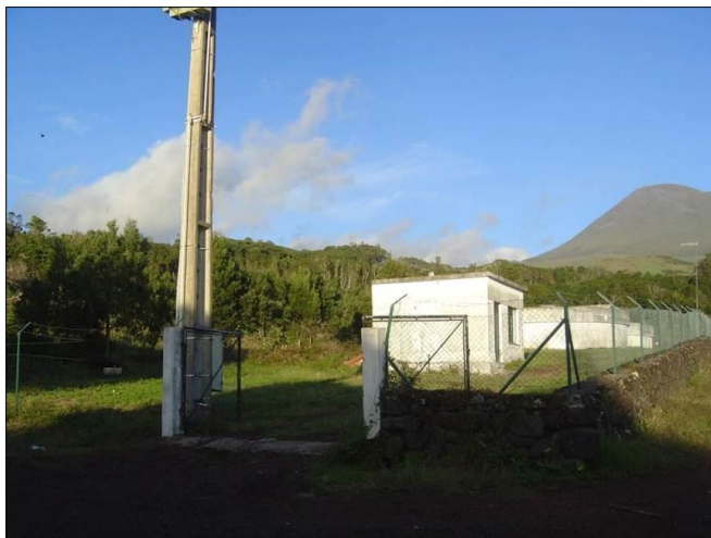
Figura 2.9.33 | Furo para abastecimento inserido em área relativamente plana.
