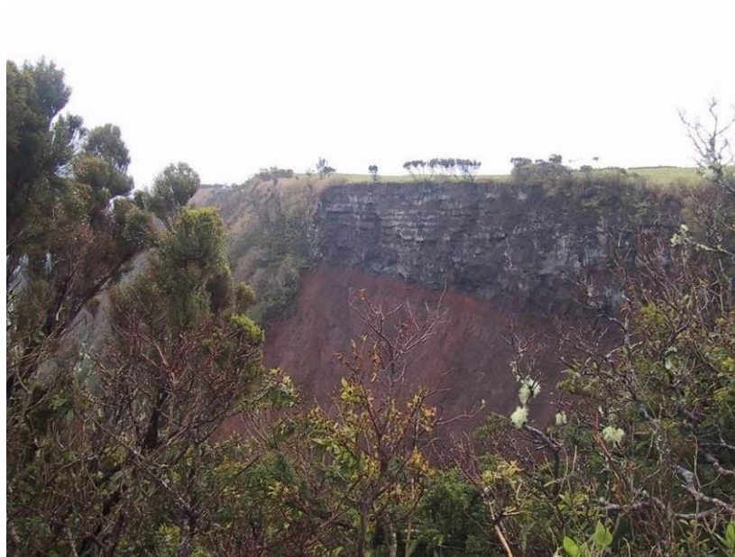
Figura 2.9.29 | Aspeto do desmonte provocado na arriba a montante da Fajã dos Cubres, provocado por um importante movimento de vertente.
