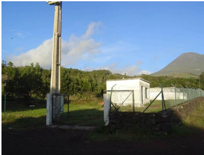
Figura 2.9.36 | Furo para abastecimento inserido em área relativamente plana.
