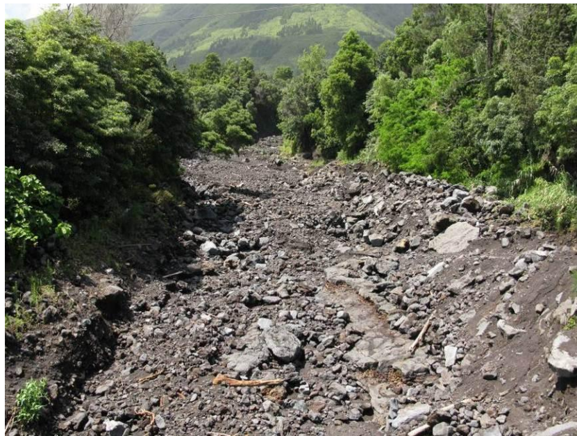
Figura 2.9.34 | Aspeto de uma estrada próxima de S. João após um período de chuva.
