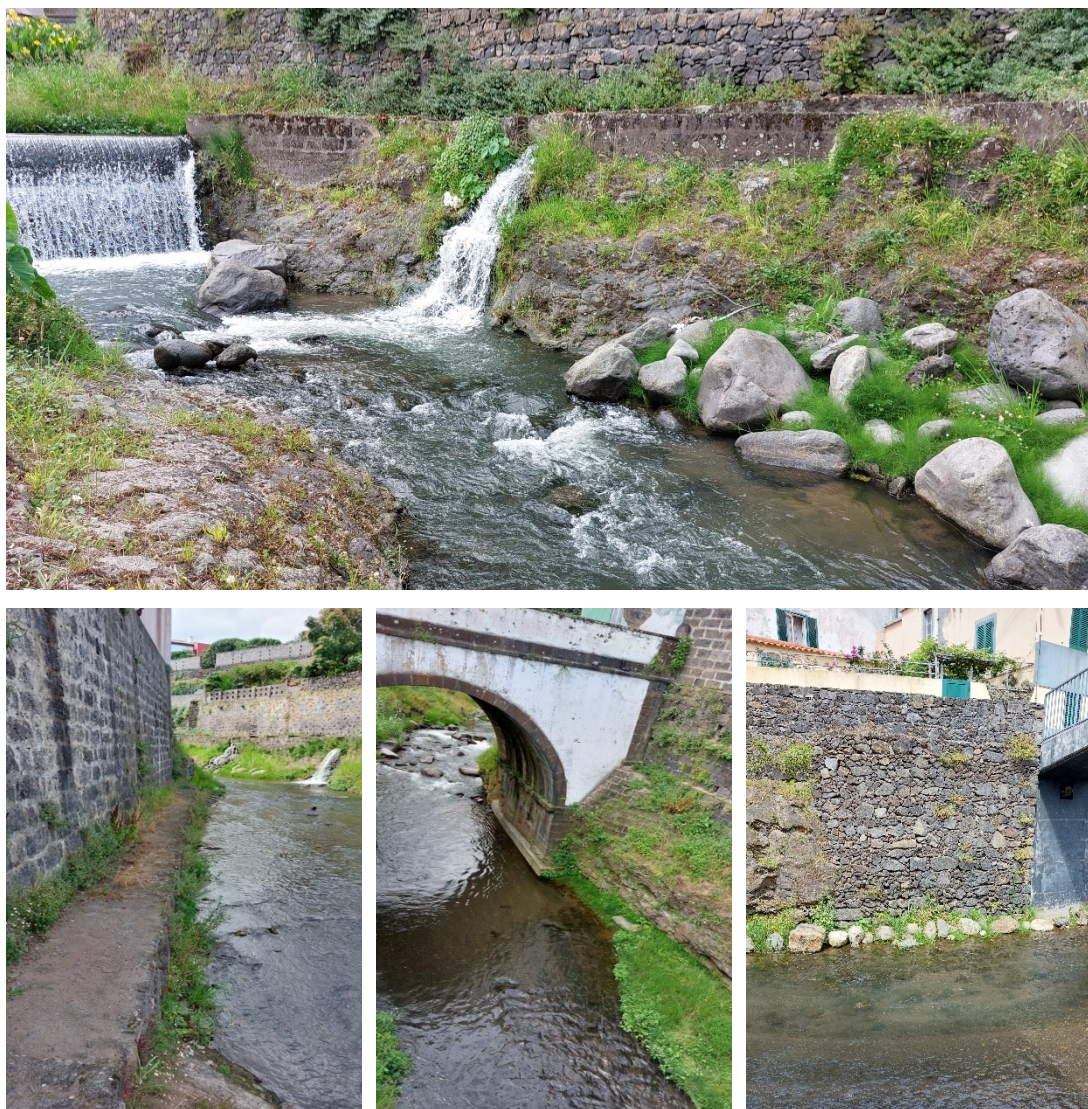
Figura 26. Ribeira Grande – Ribeira Grande (Ilha de São Miguel). Em cima: vista geral do troço analisado e da sua artificialização; Em baixo: detalhes das principais alterações no habitat.
