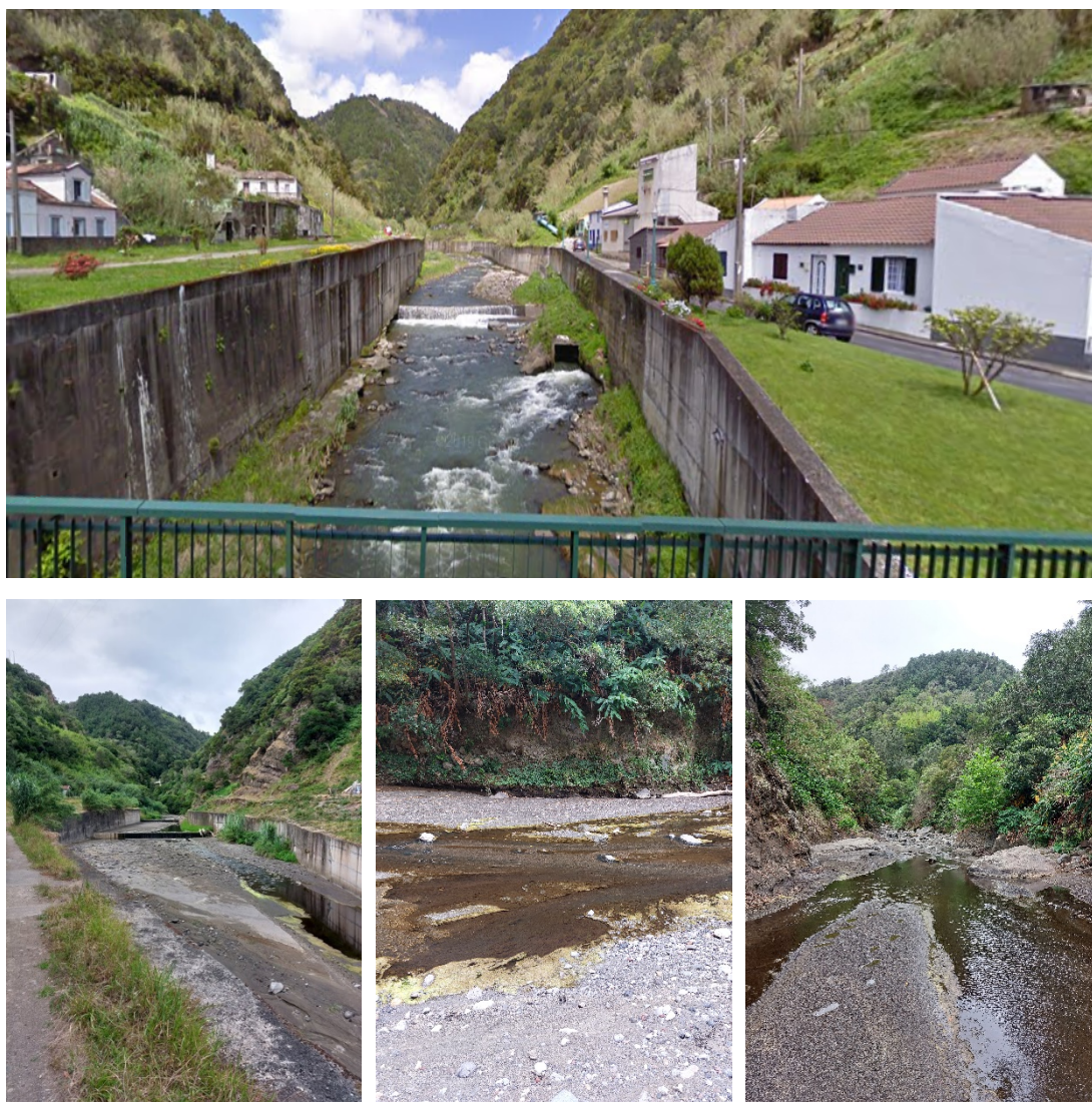
Figura 7. Ribeira Quente – Ribeira Quente (Ilha de São Miguel). Em cima: vista geral do troço analisado mostrando re-seccionamento e reforço das margens, urbanização e descarga de água de hidroelétrica; Em baixo: detalhes de outras características e alterações no habitat.
