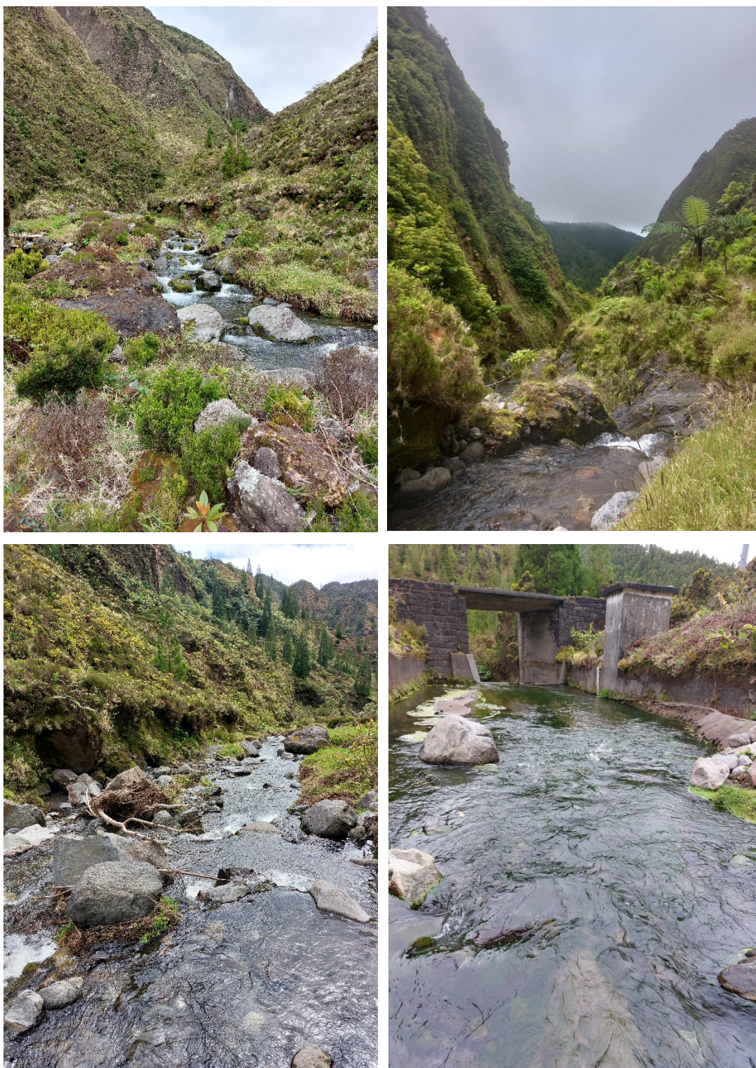
Figura 22. Ribeira Grande – Lombadas-Rosário (Ilha de São Miguel). Vistas gerais do troço analisado e em baixo à direita detalhe do reforço das margens e ponte.
