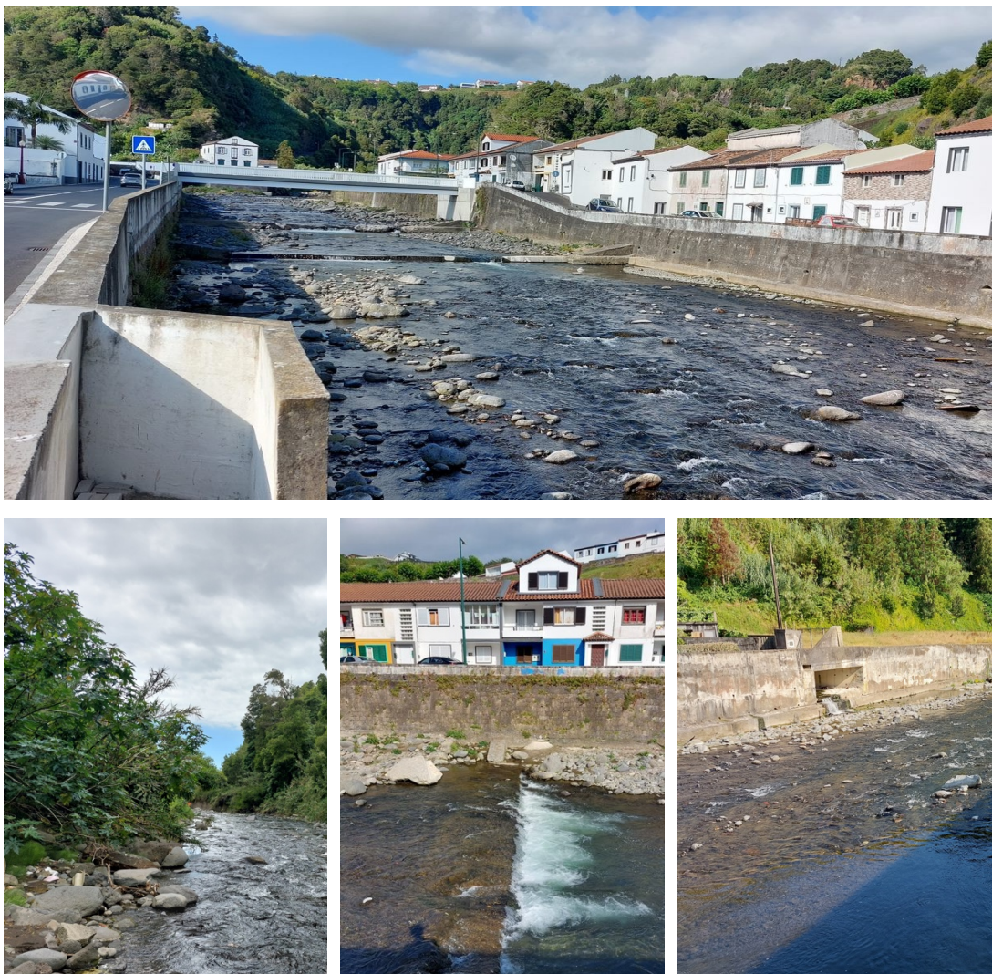
Figura 9. Ribeira da Povoação – Povoação (Ilha de São Miguel). Em cima: vista geral do troço analisado mostrando re-seccionamento e reforço das margens, açudes e intensa urbanização; Em baixo: detalhes de alterações no habitat.
