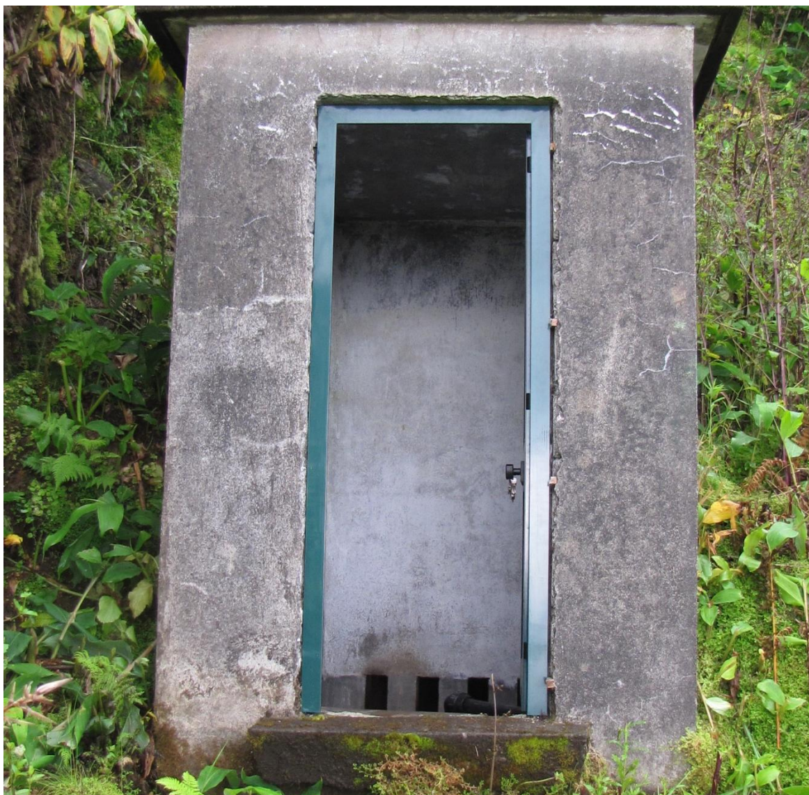
Vista geral do ponto de água.
