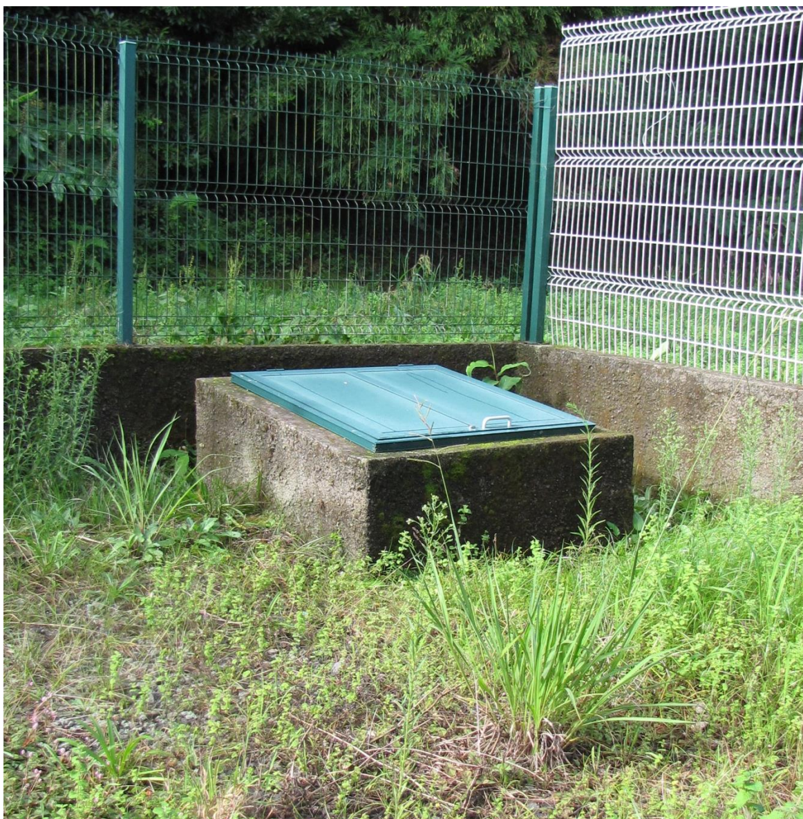
Vista geral do ponto de água.
