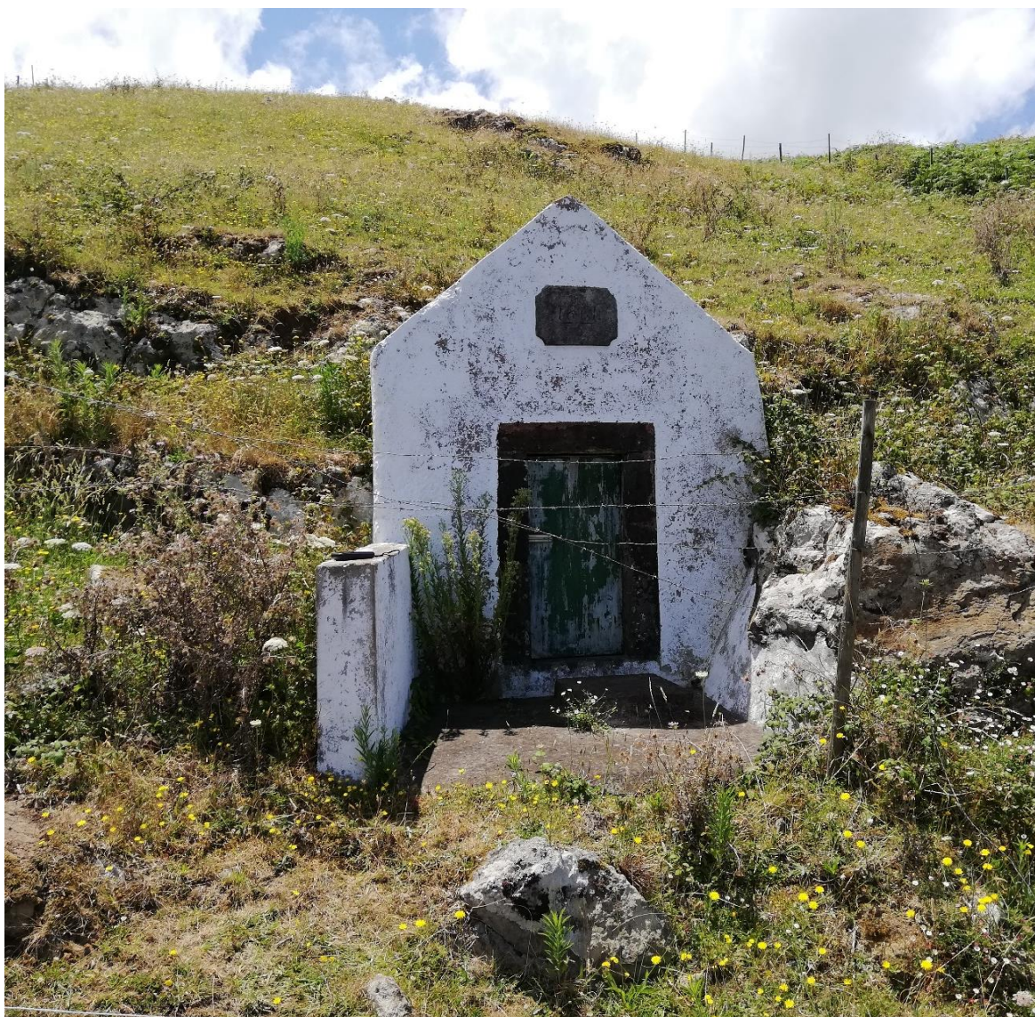
Vista geral do ponto de água.
