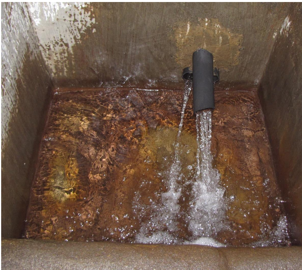
Pormenor do ponto de água.
