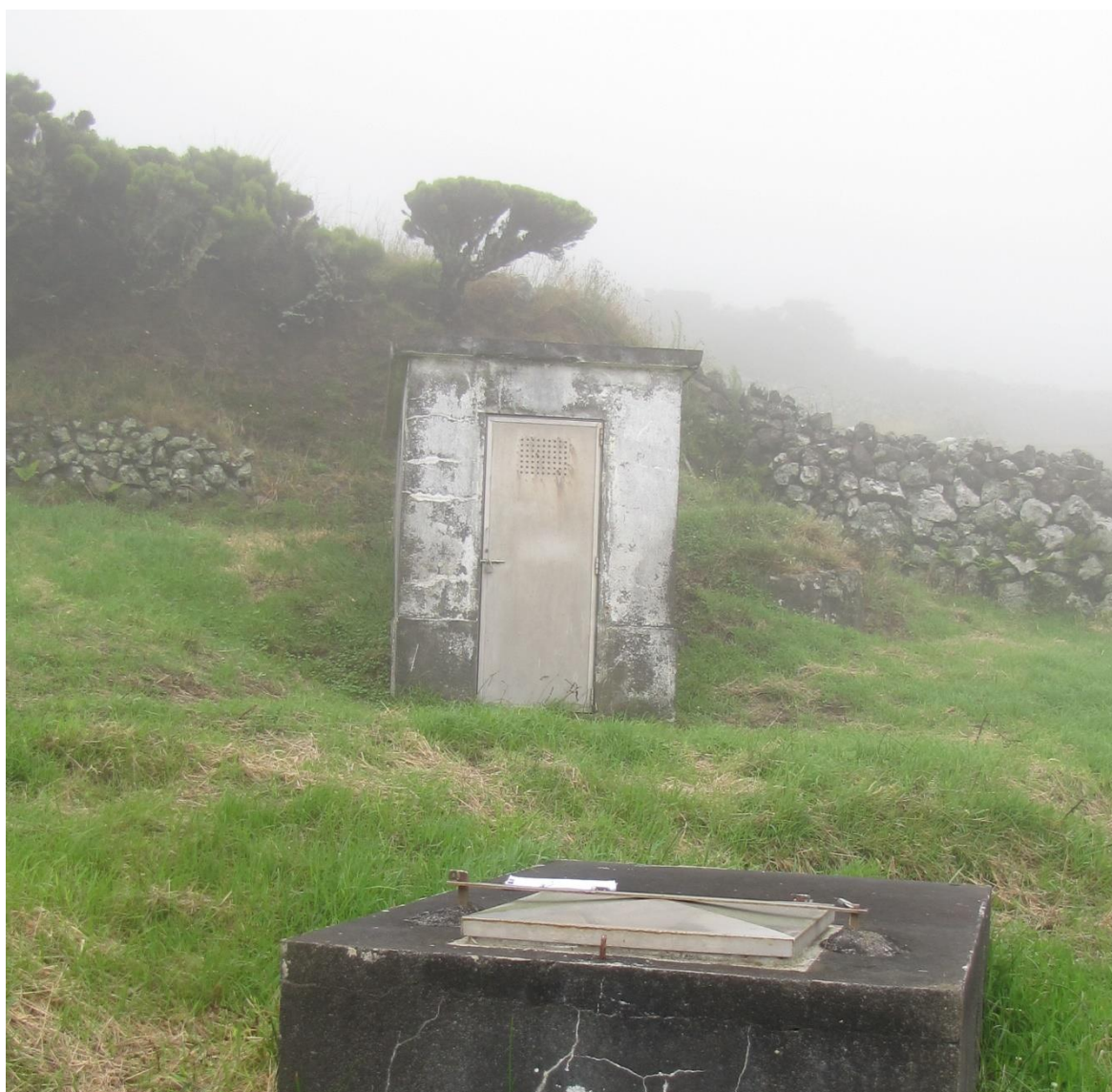
Vista geral do ponto de água.
