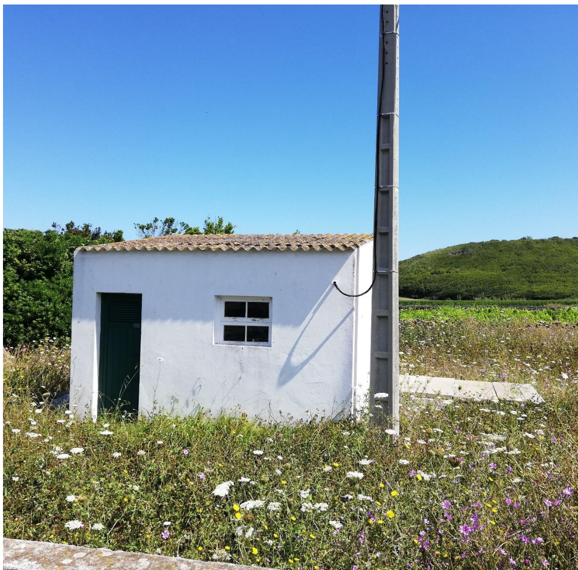
Vista geral do ponto de água.
