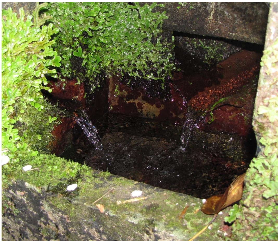
Pormenor do ponto de água.
