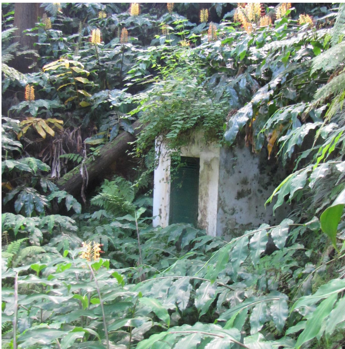
Vista geral do ponto de água.
