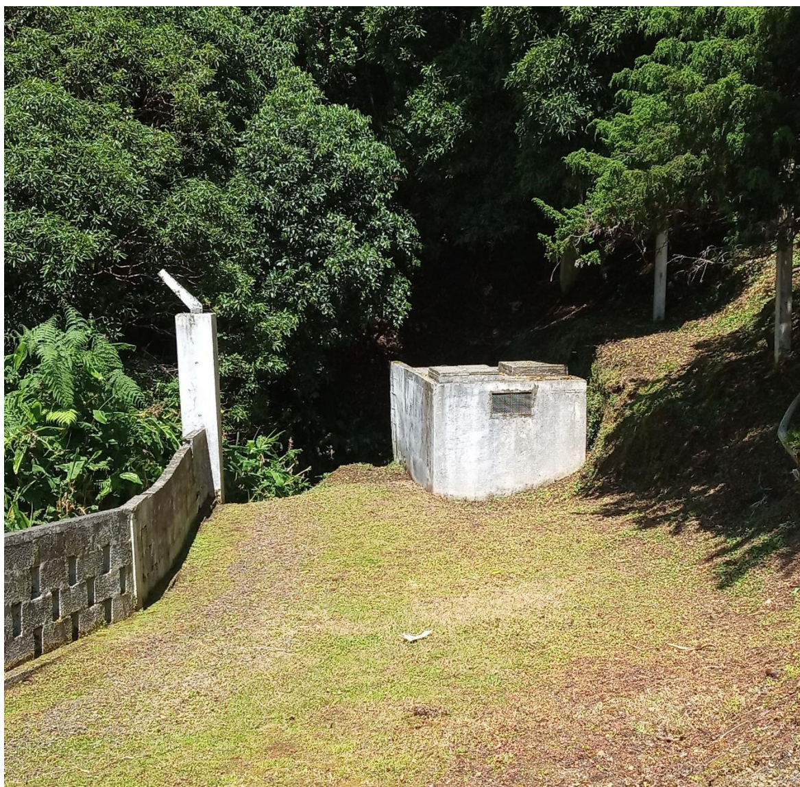
Vista geral do ponto de água.
