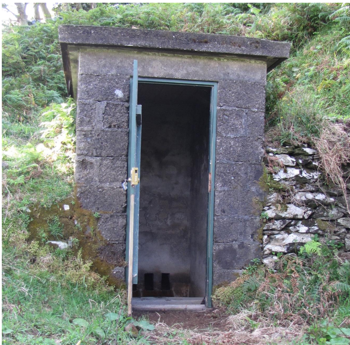
Vista geral do ponto de água.
