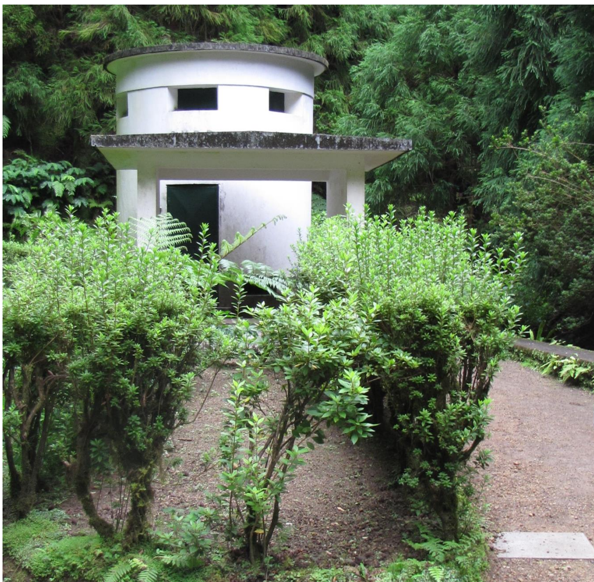
Vista geral do ponto de água.
