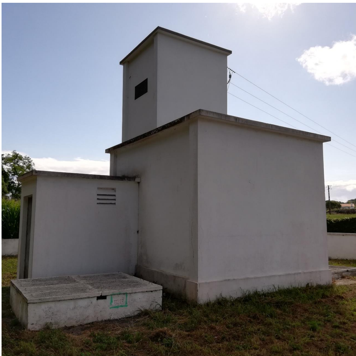
Vista geral do ponto de água.
