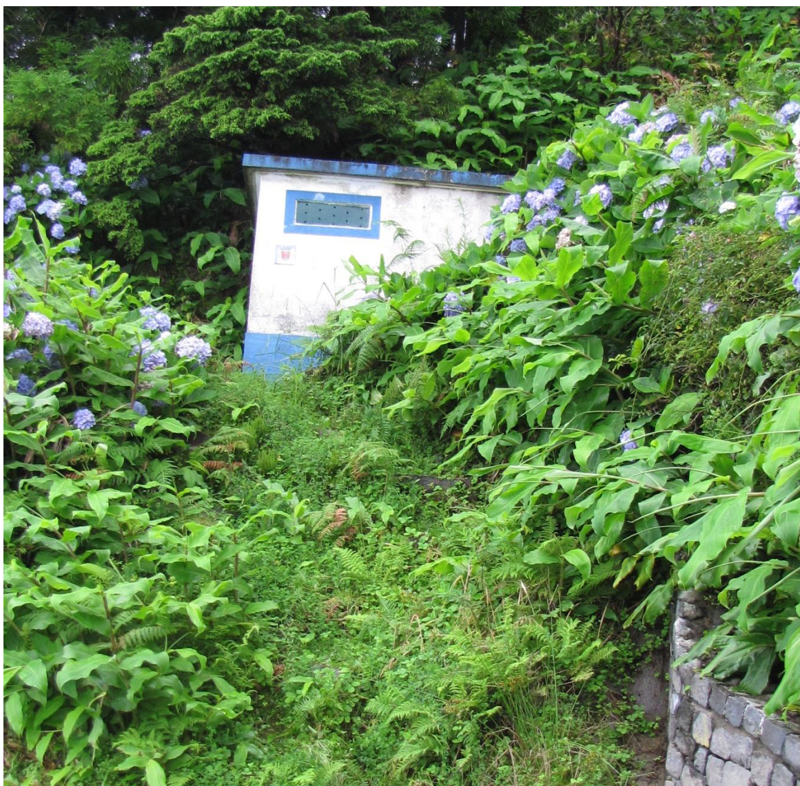
Vista geral do ponto de água.
