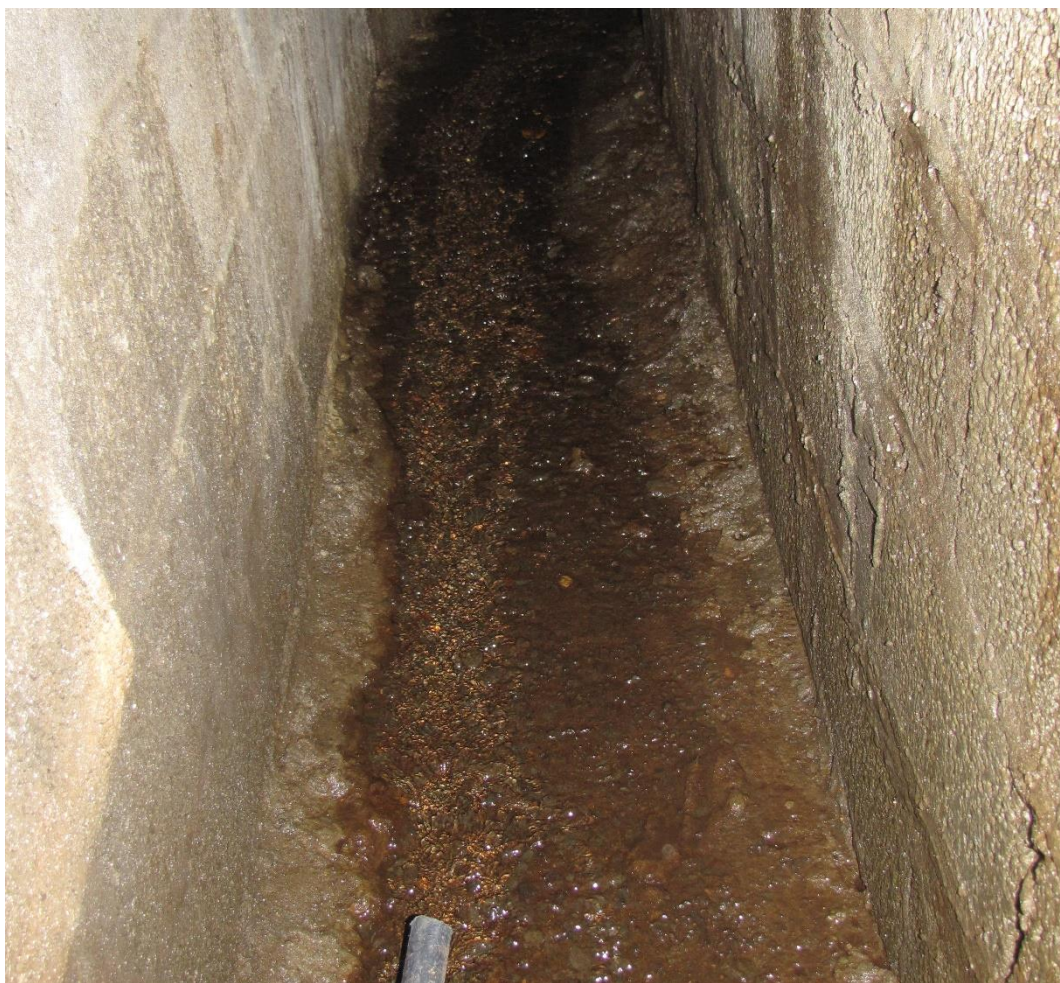
Pormenor do ponto de água.
