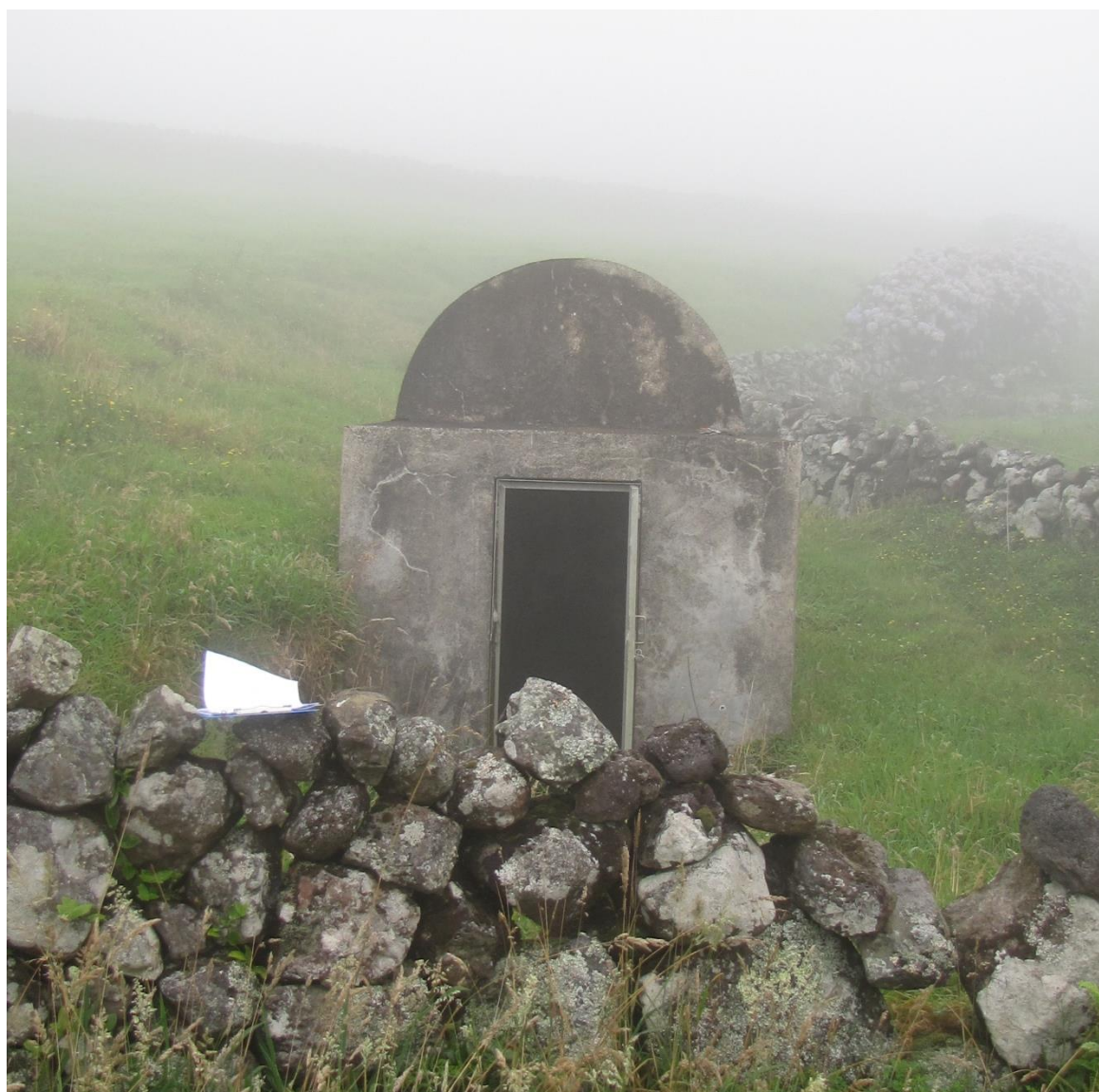
Vista geral do ponto de água.
