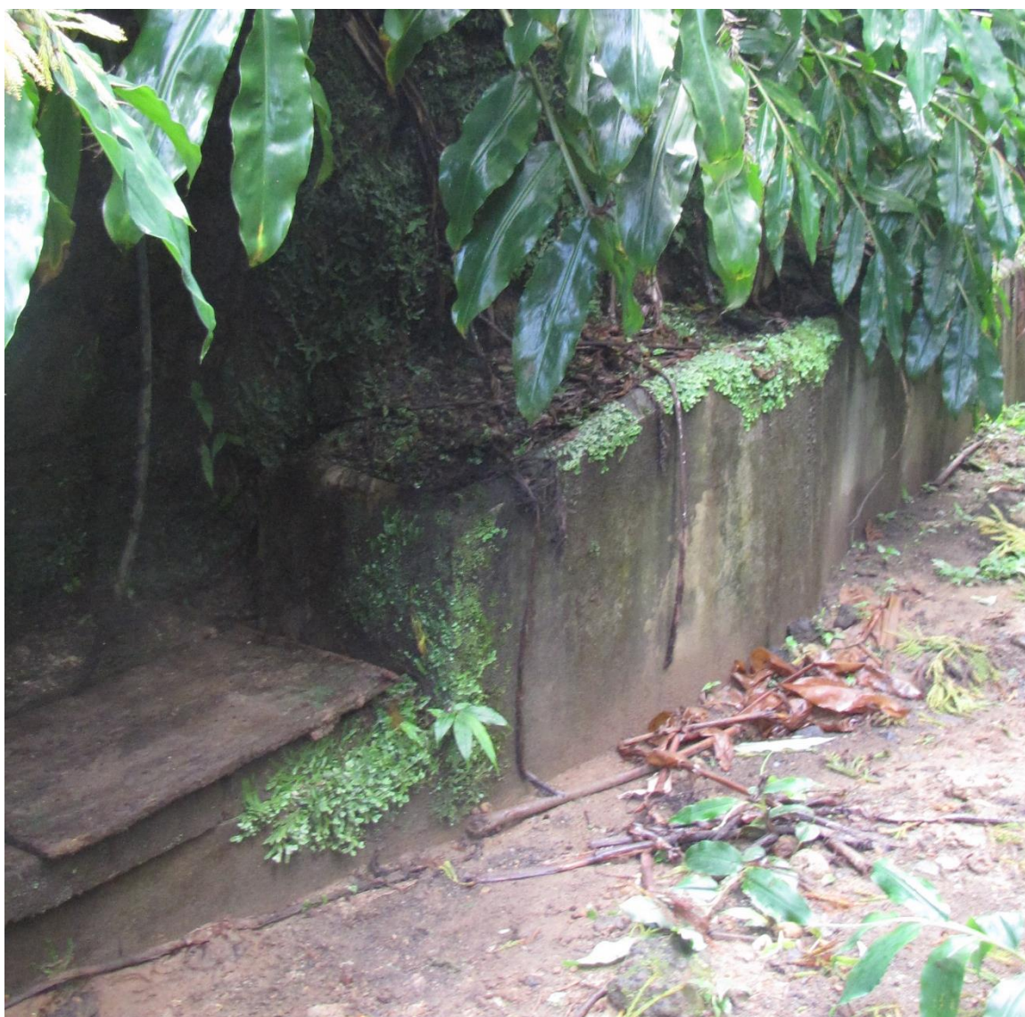
Vista geral do ponto de água.
