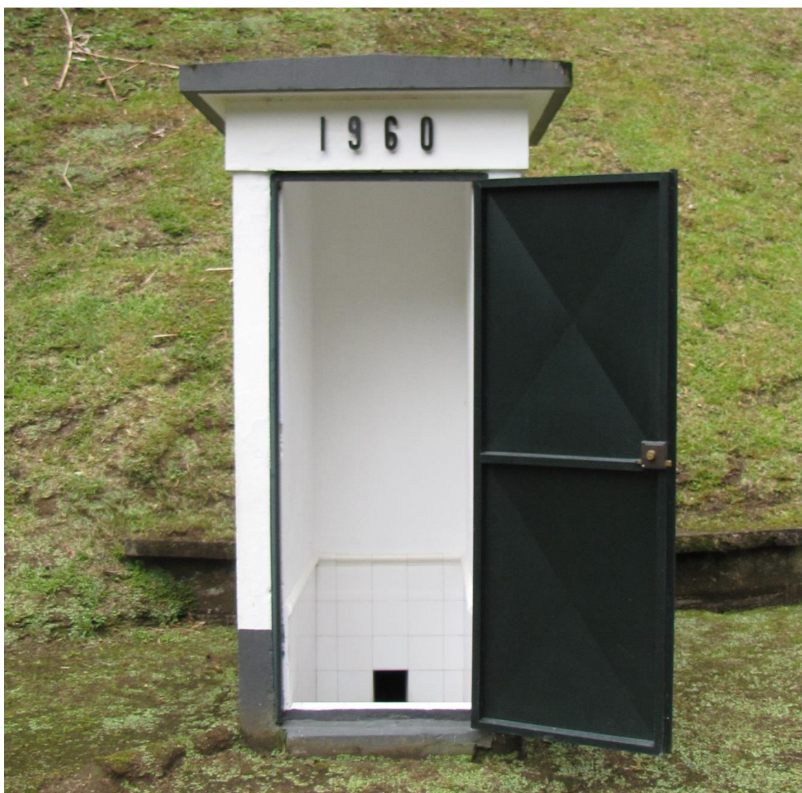
Vista geral do ponto de água.
