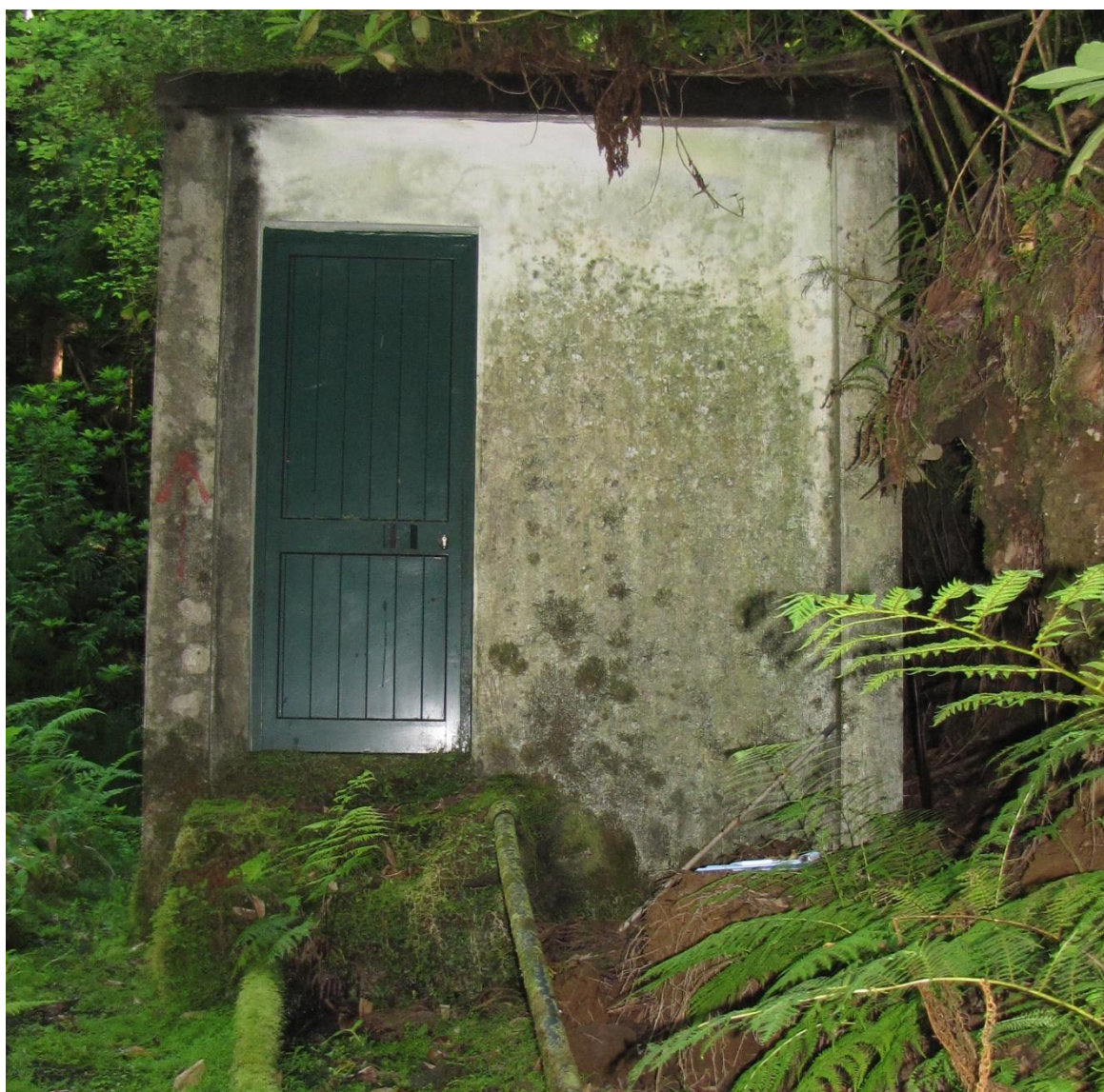
Vista geral do ponto de água.
