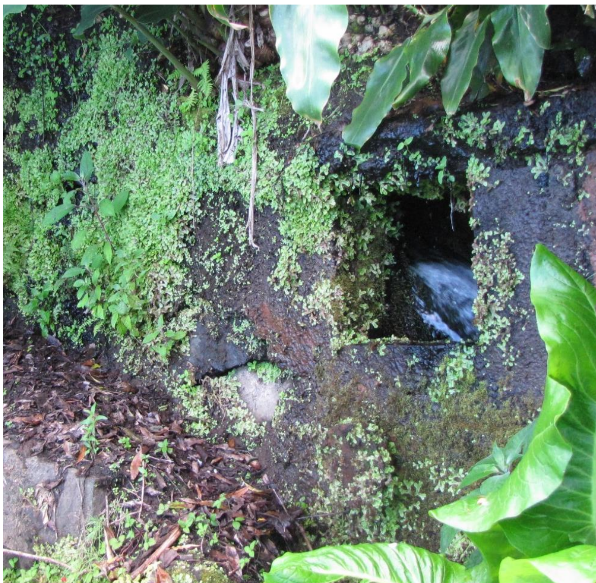
Vista geral do ponto de água.
