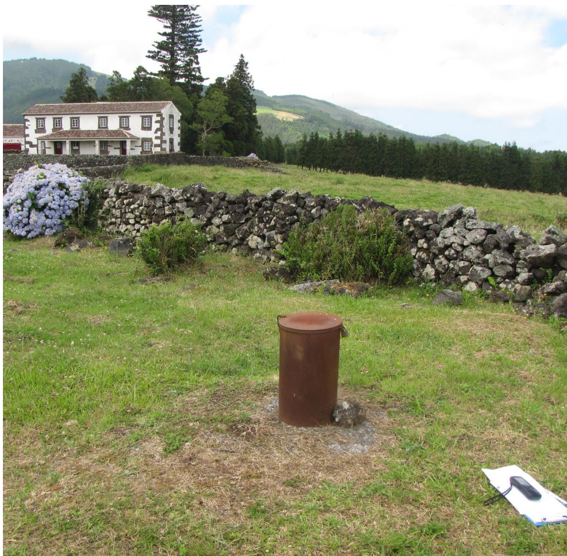
Vista geral do ponto de água.
