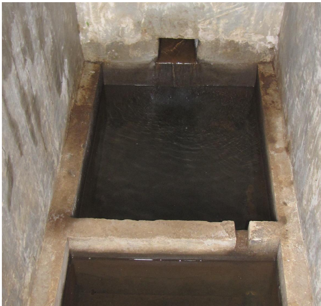
Pormenor do ponto de água.
