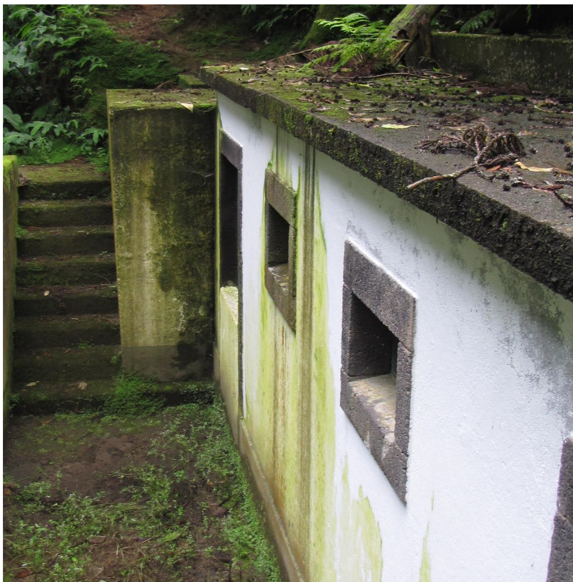
Vista geral do ponto de água.
