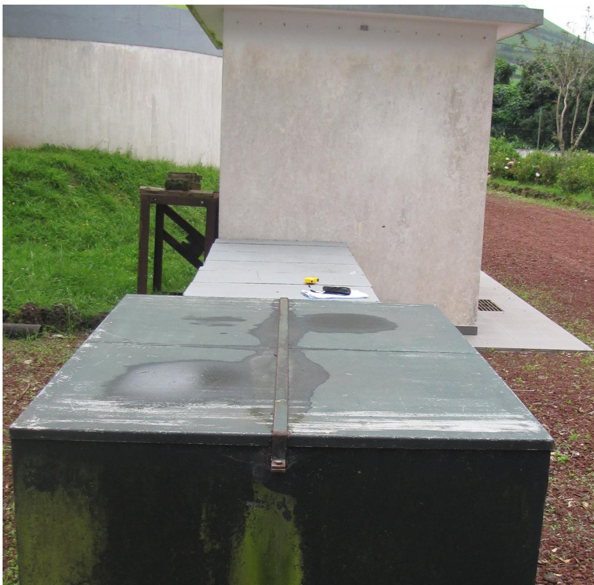
Vista geral do ponto de água.
