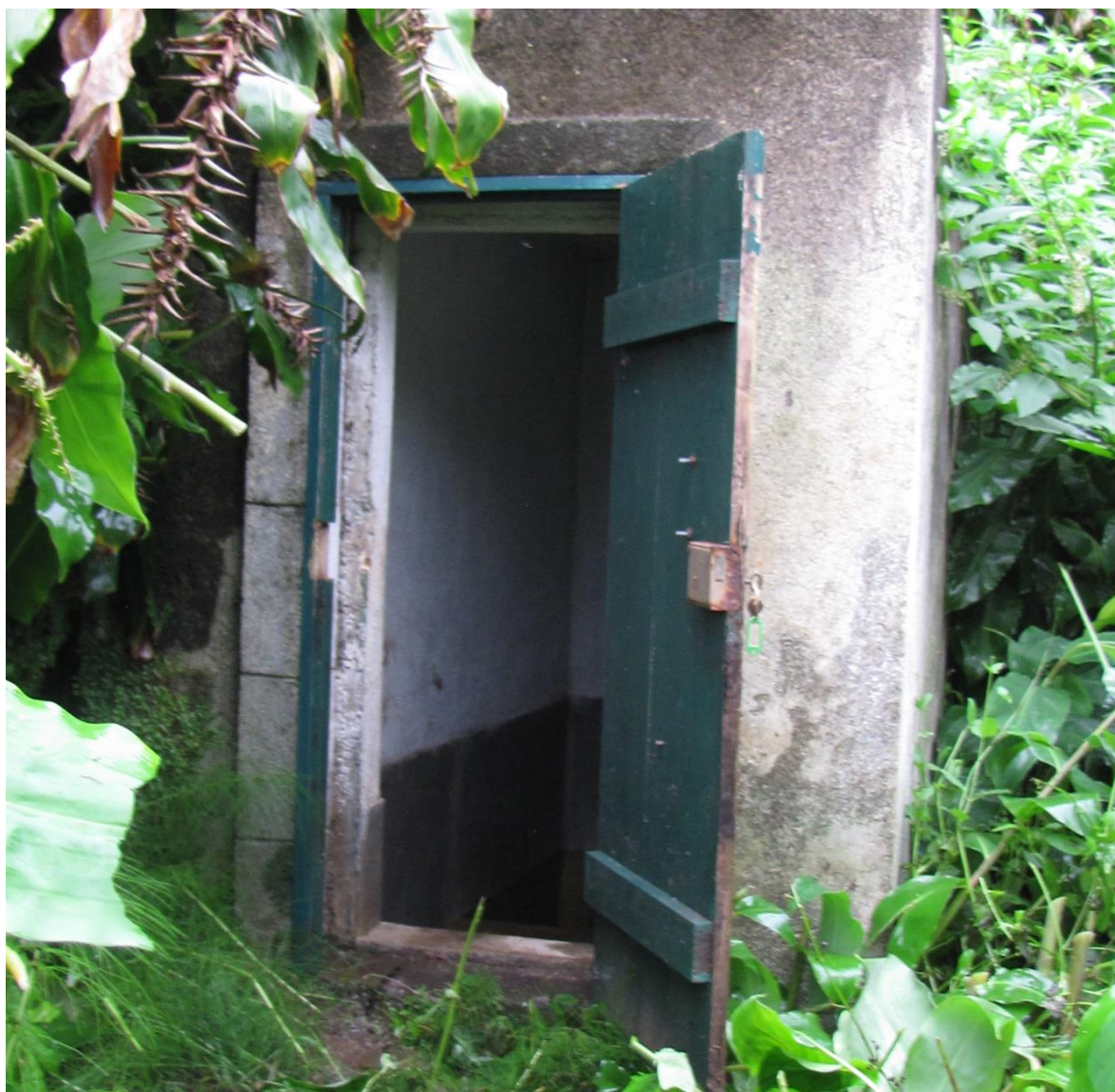
Vista geral do ponto de água.
