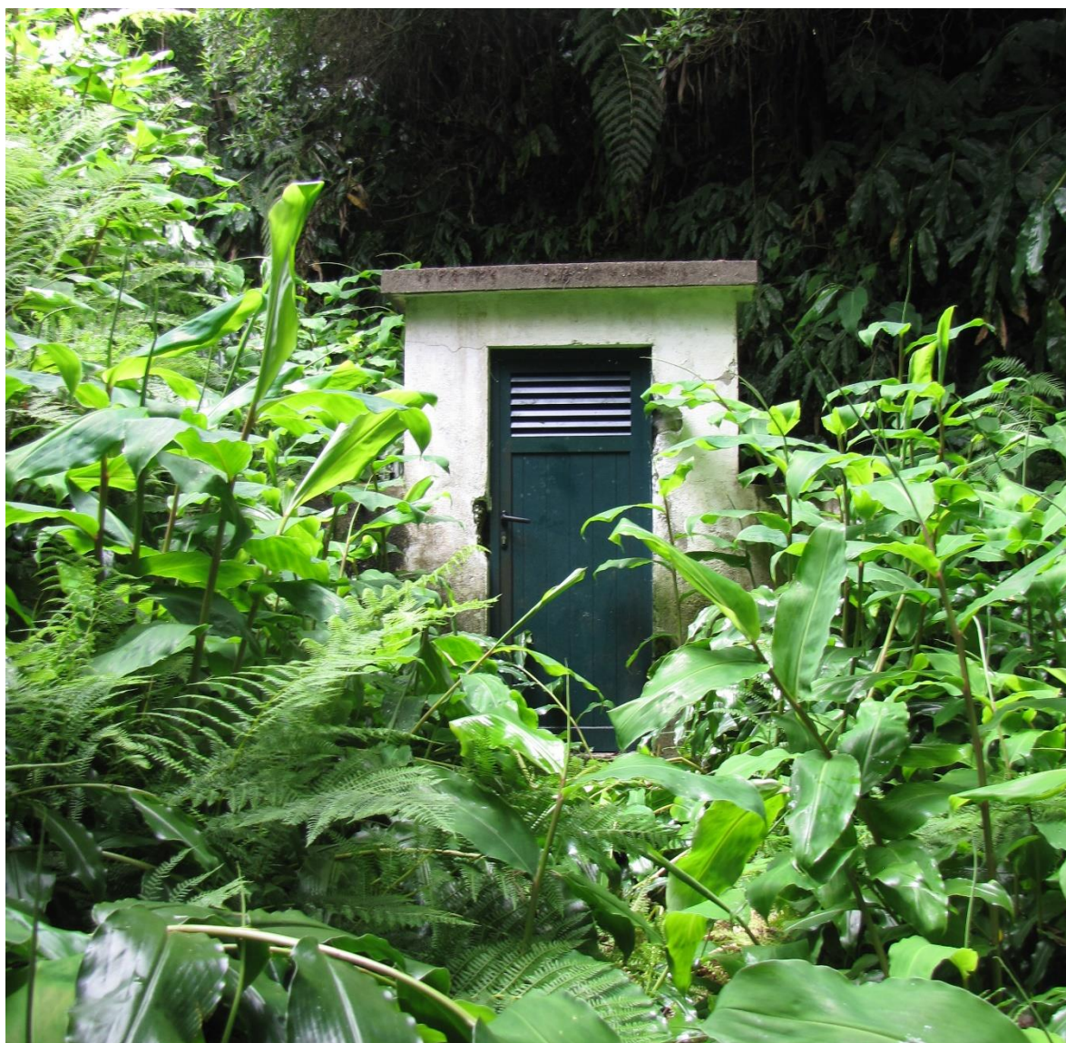
Figura 1| Vista geral do ponto de água
