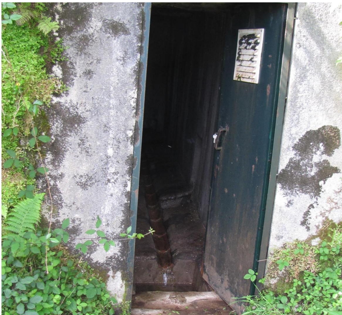
Vista geral do ponto de água
