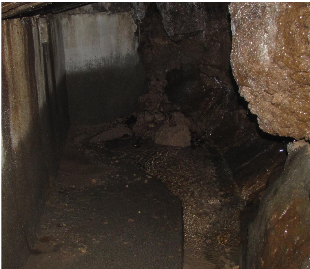
Pormenor do ponto de água.
