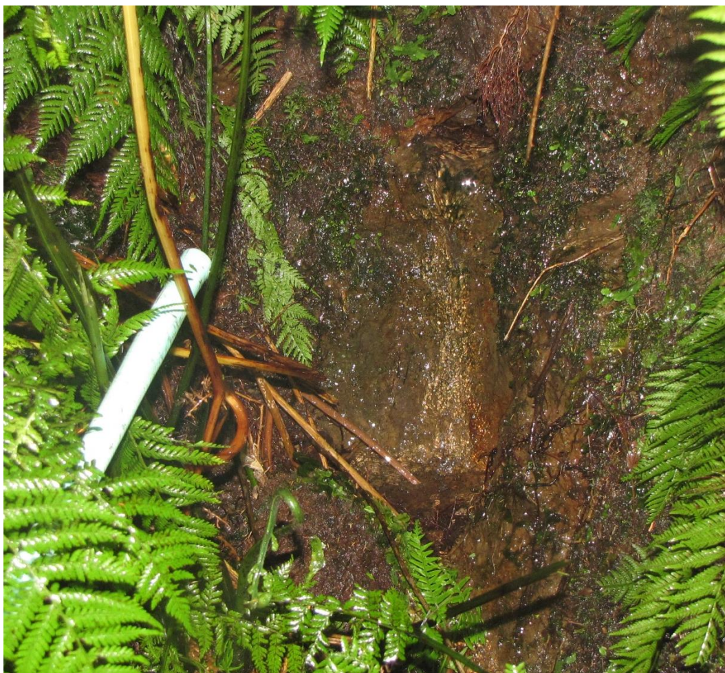
Pormenor do ponto de água.
