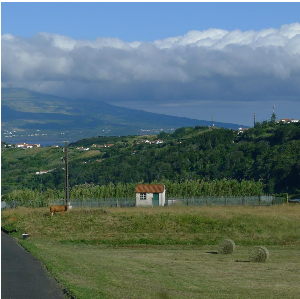
Vista geral do ponto de água.
