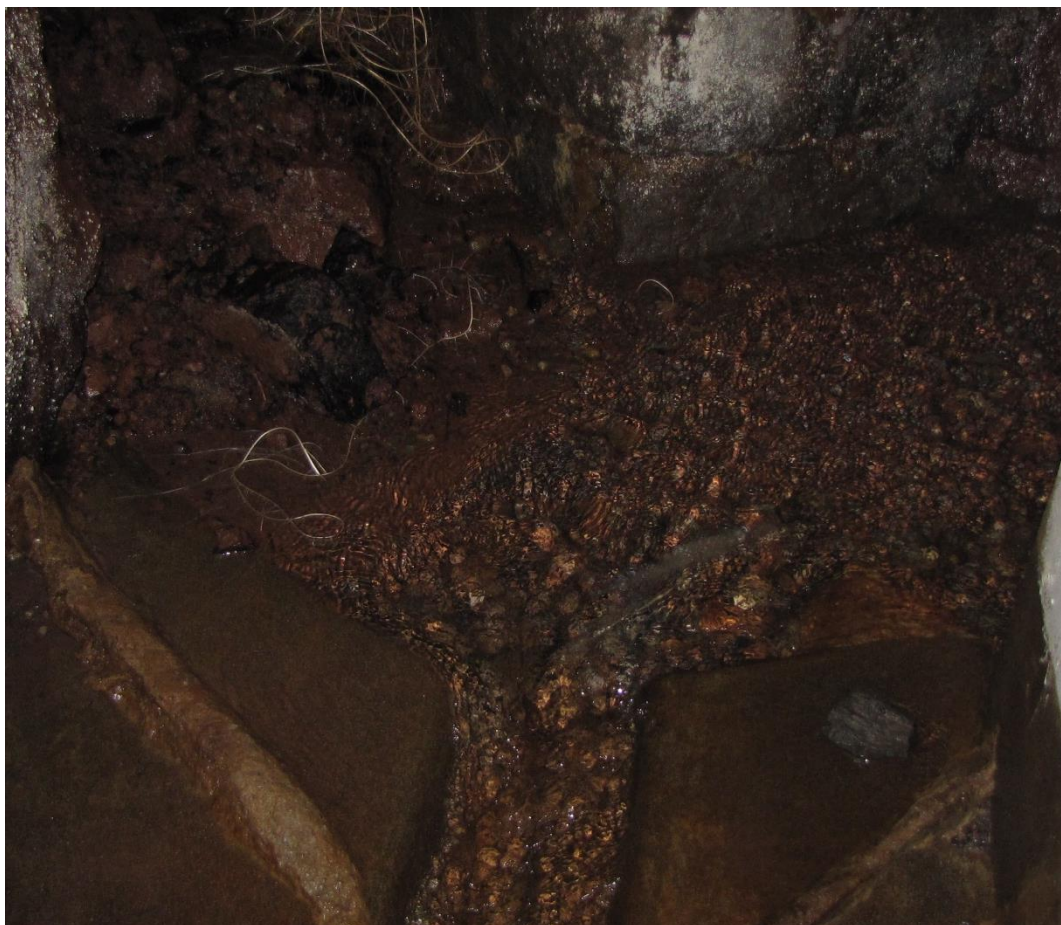
Pormenor do ponto de água.
