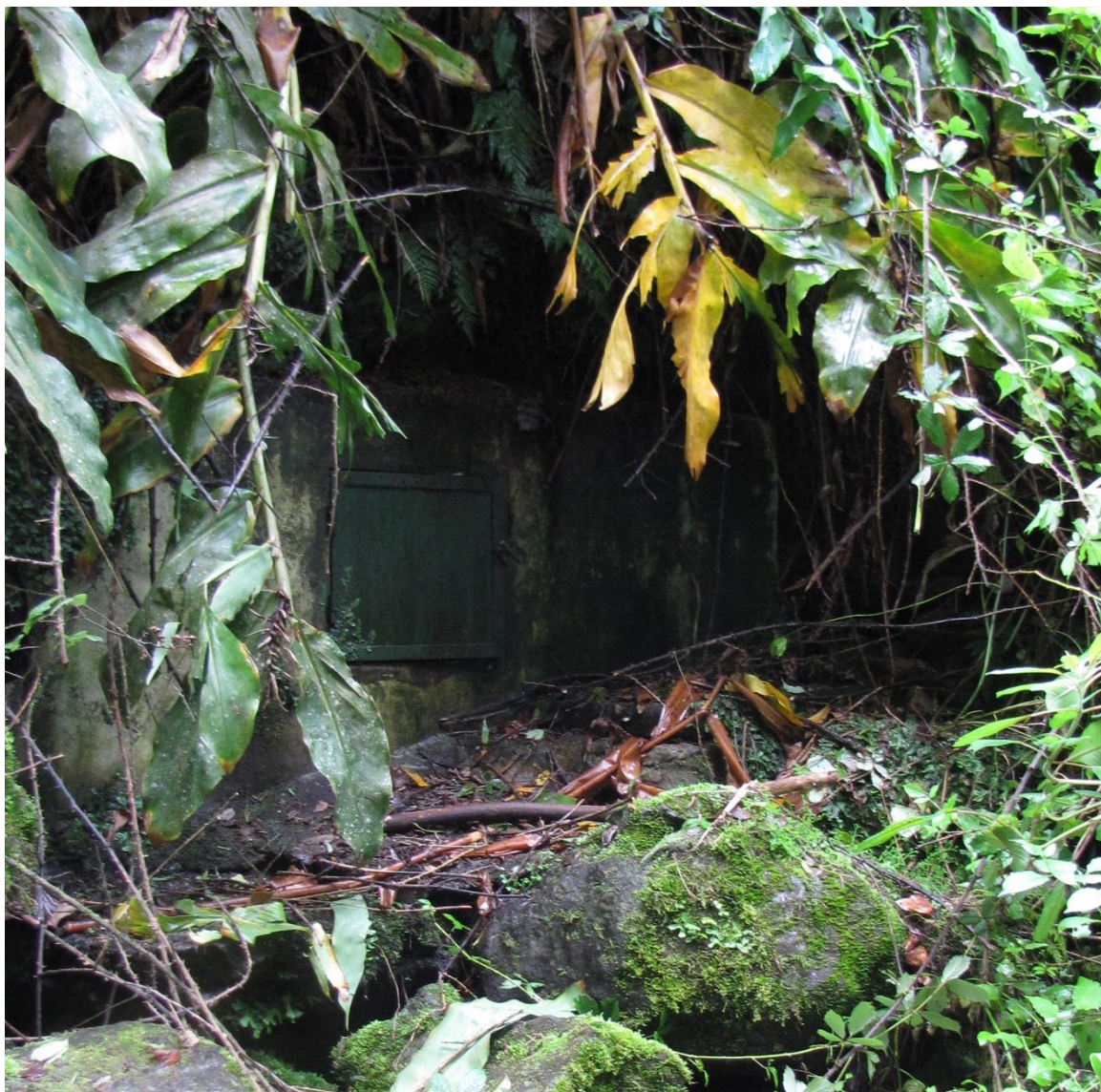
Vista geral do ponto de água.
