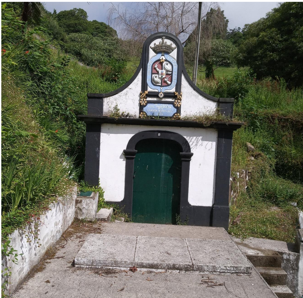
Vista geral do ponto de água.
