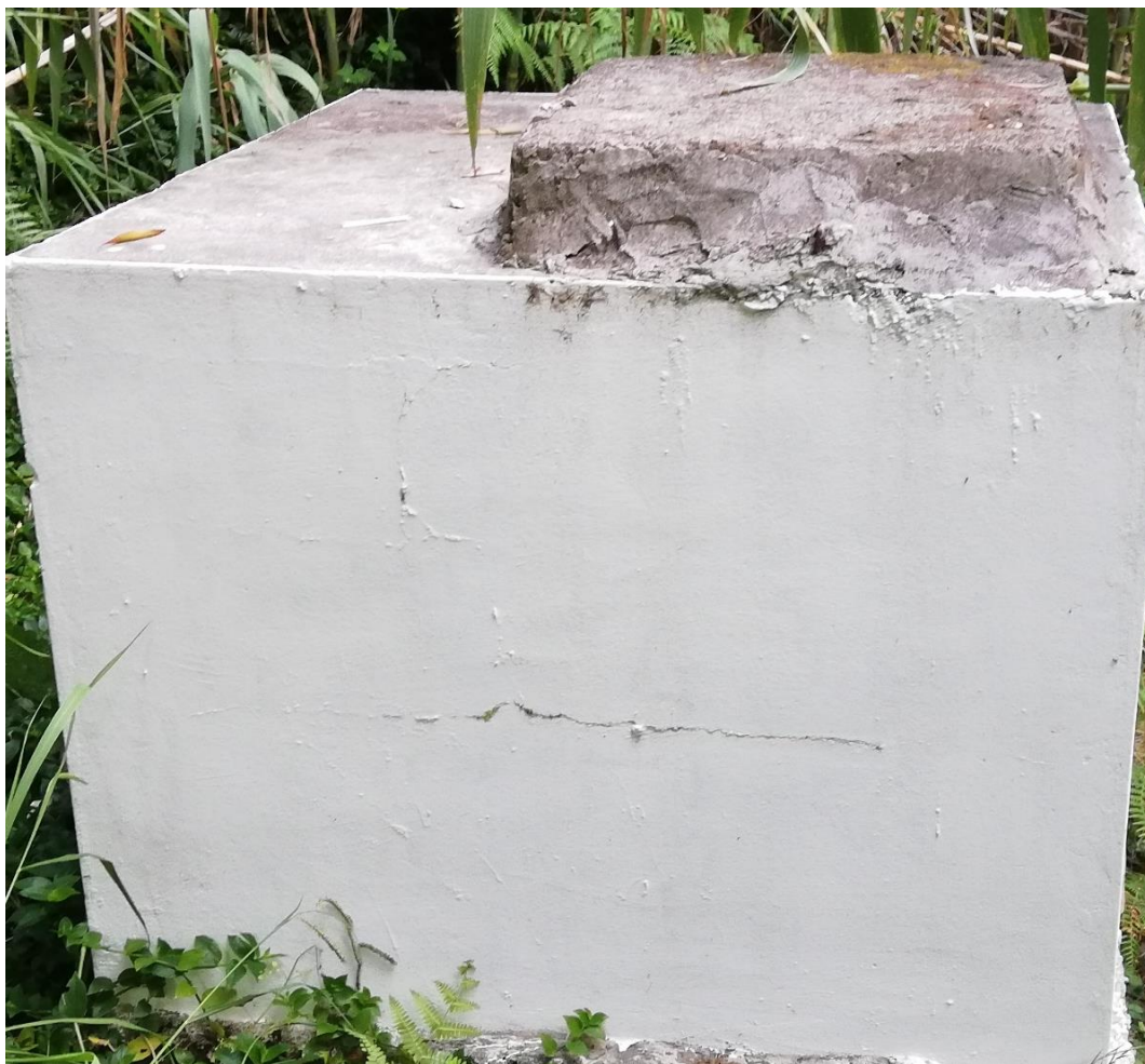
Pormenor do ponto de água.
