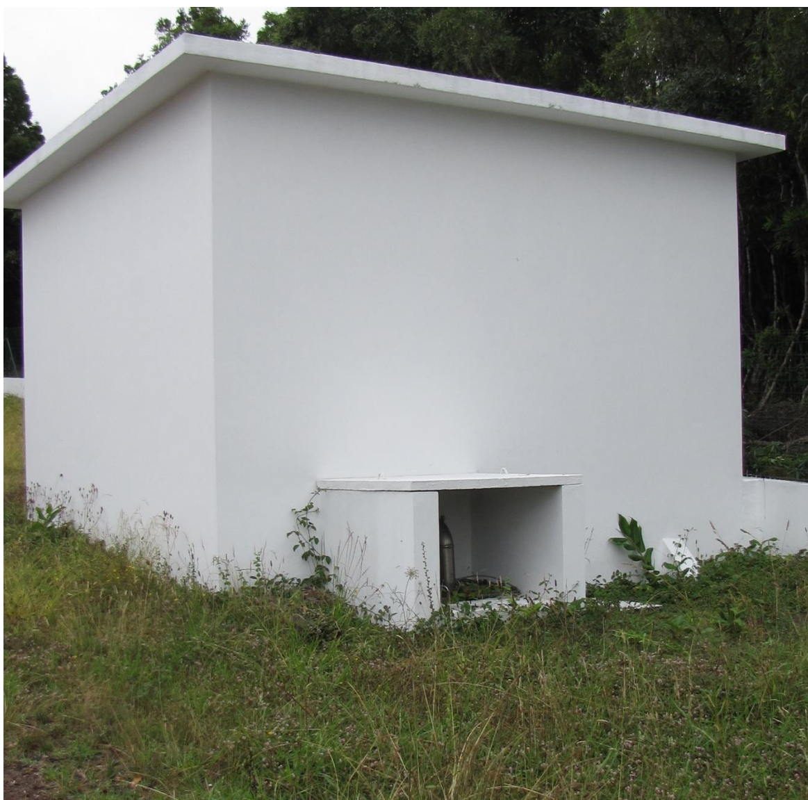
Vista geral do ponto de água.
