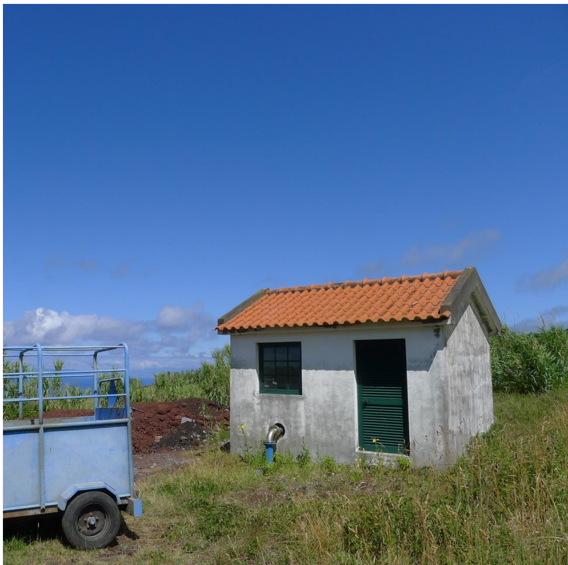
Vista geral do ponto de água.
