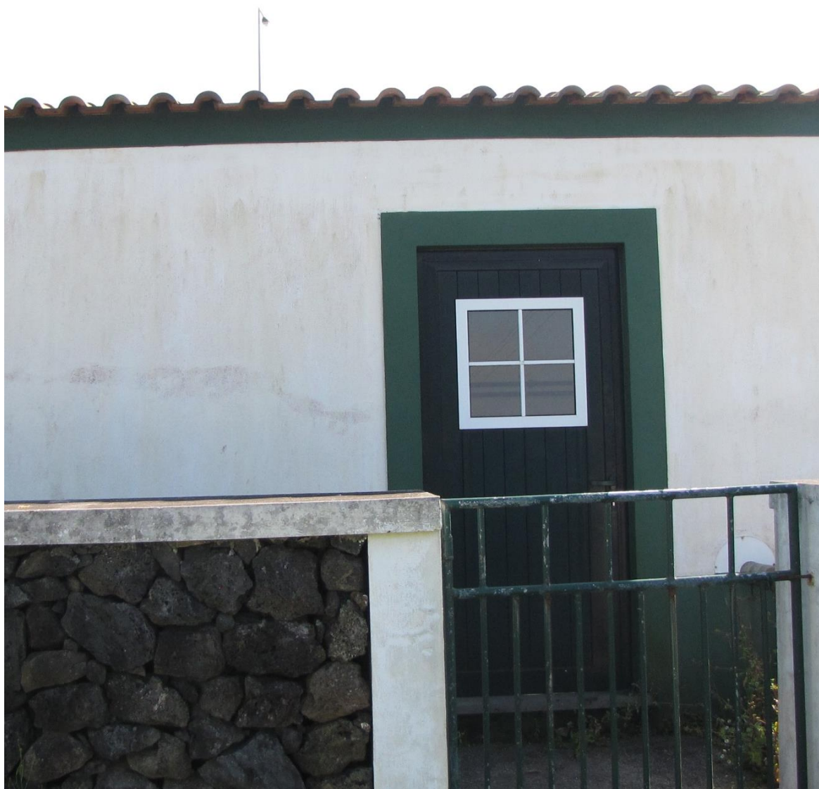
Vista geral do ponto de água.
