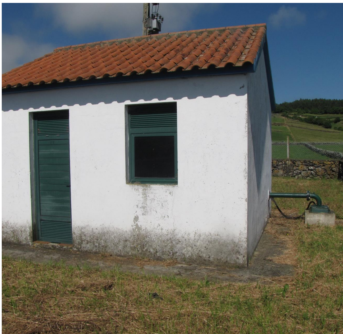
Vista geral do ponto de água.
