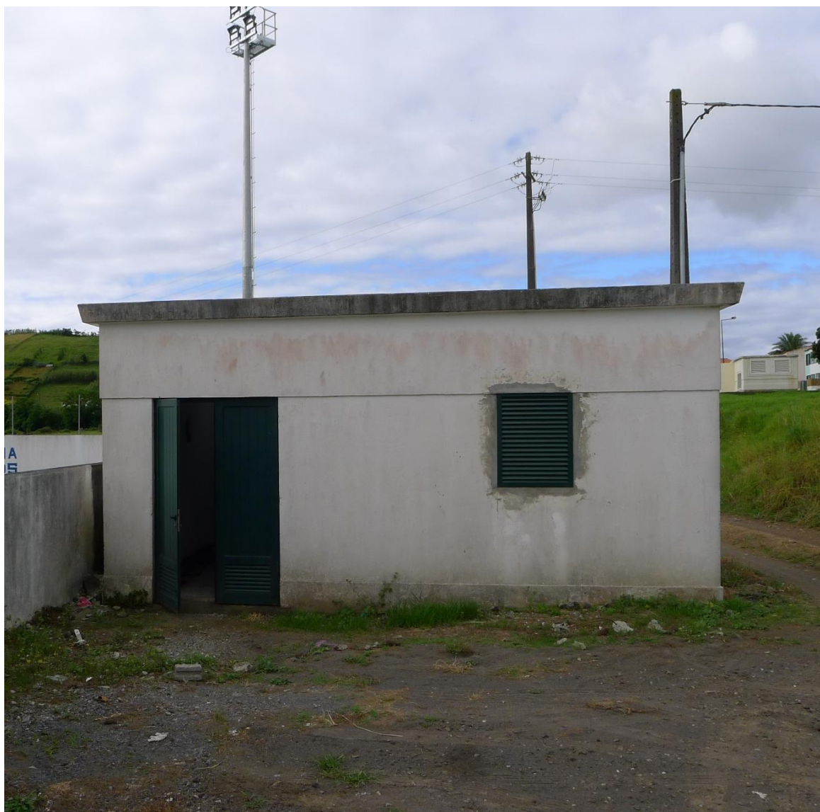
Vista geral do ponto de água.
