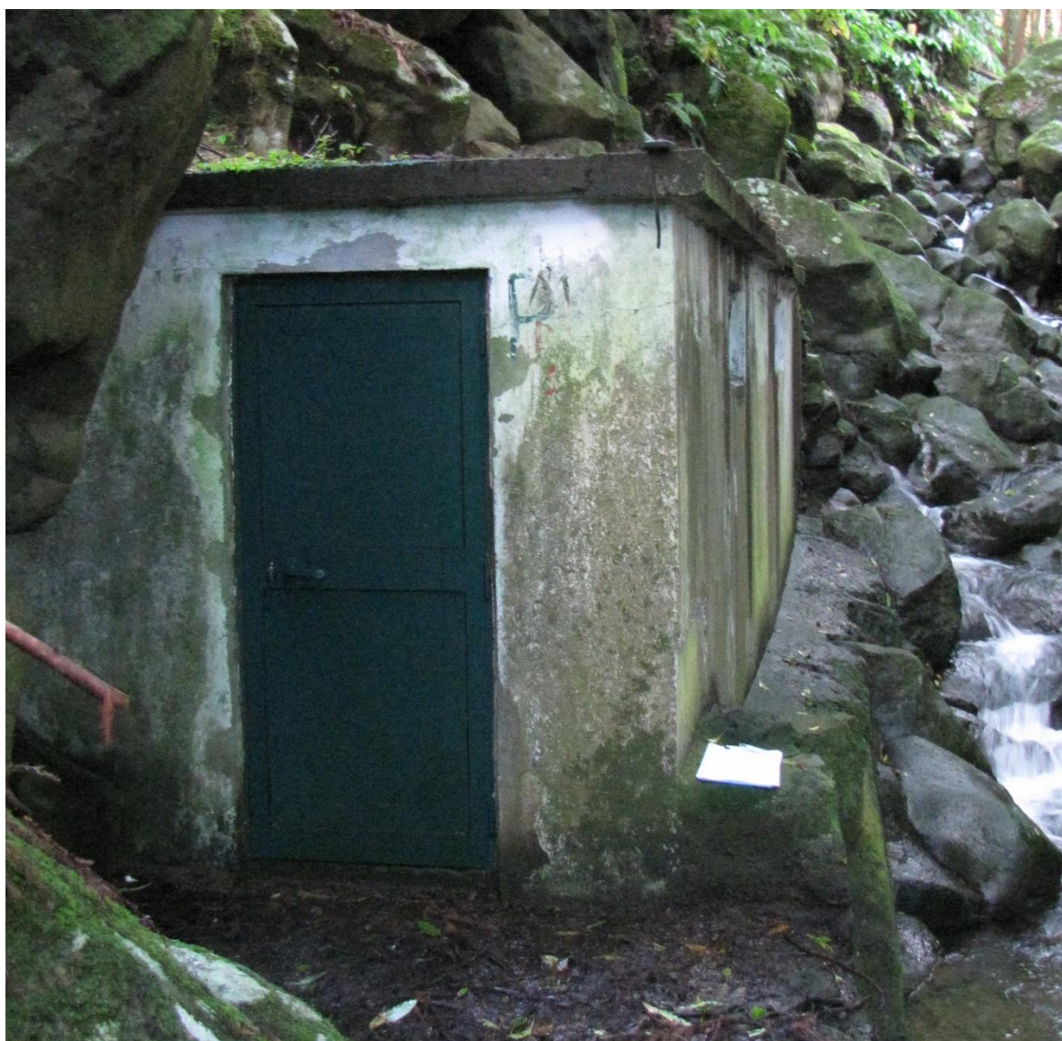
Vista geral do ponto de água.
