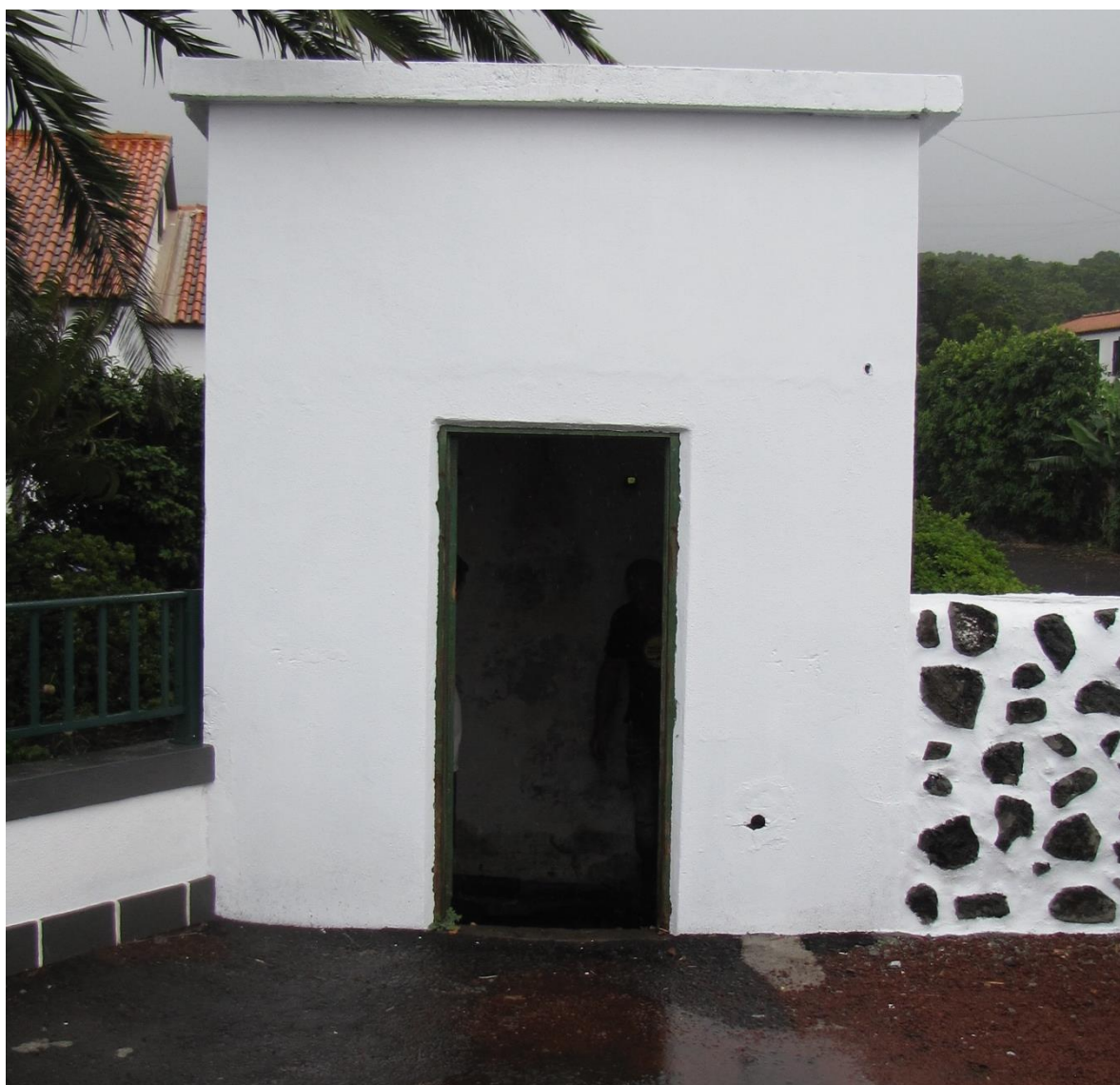
Vista geral do ponto de água.
