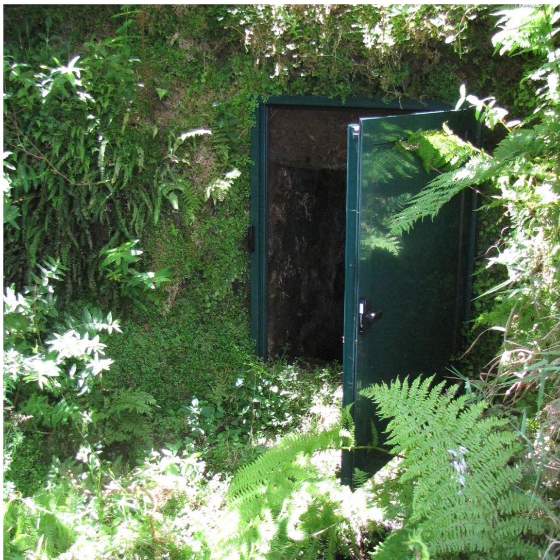
Vista geral do ponto de água.
