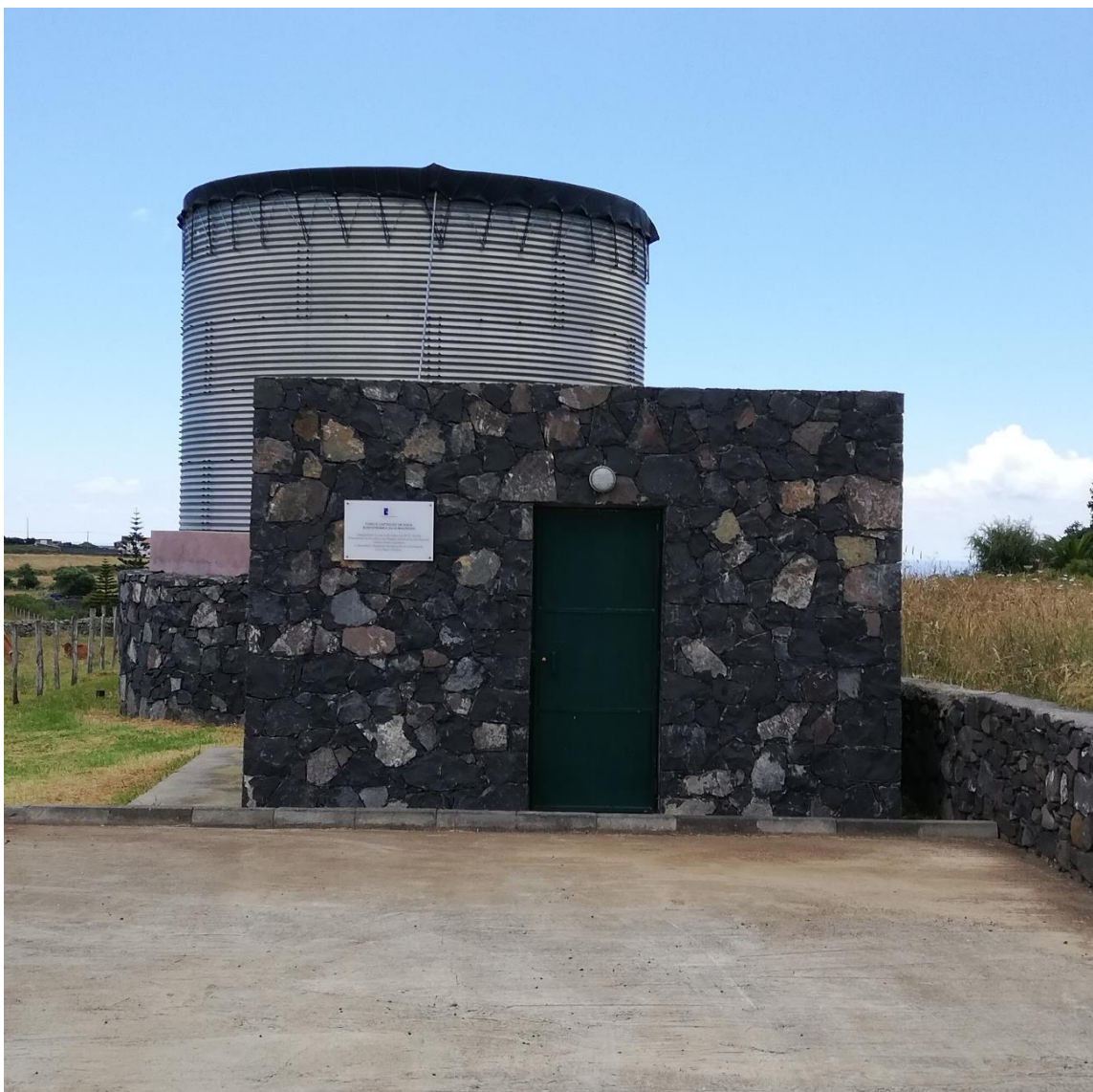
Vista geral do ponto de água.
