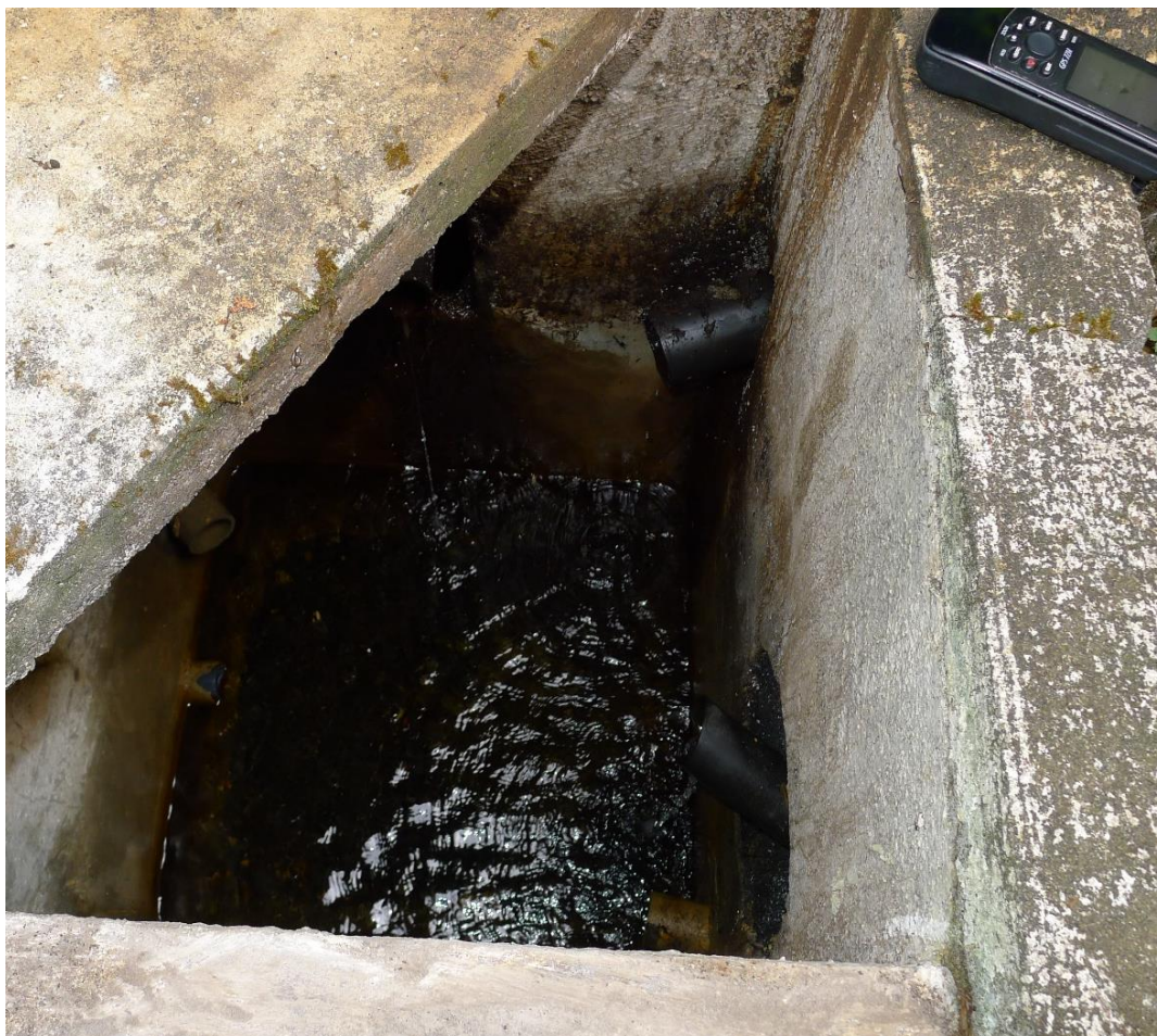
Pormenor do ponto de água.
