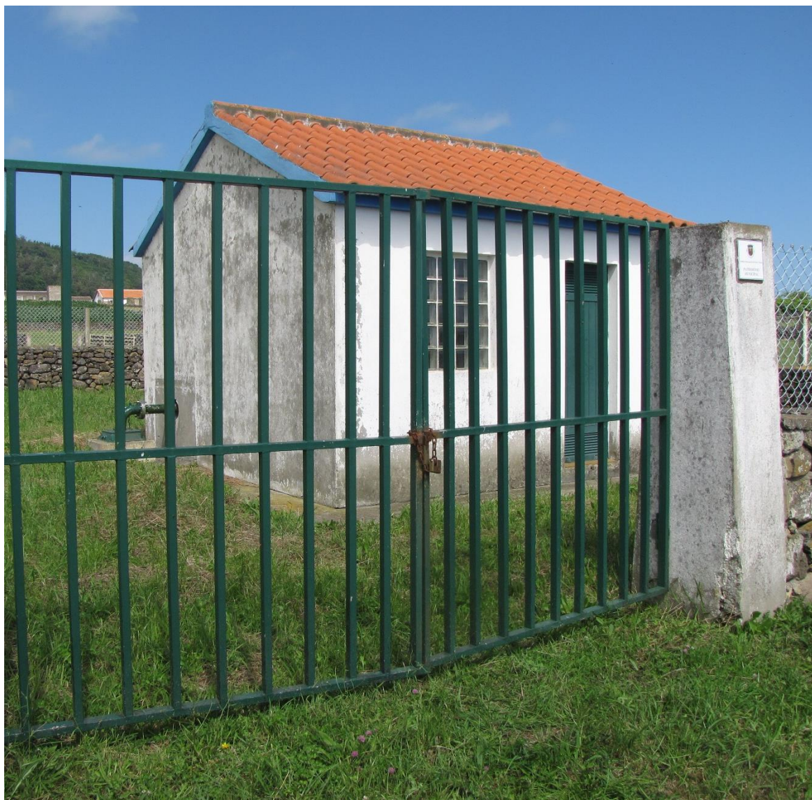
Vista geral do ponto de água.
