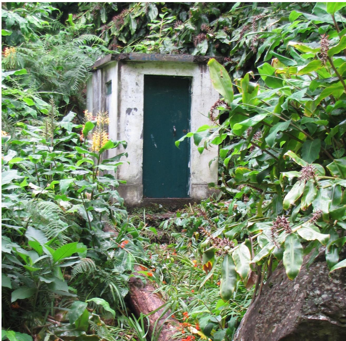
Vista geral do ponto de água.
