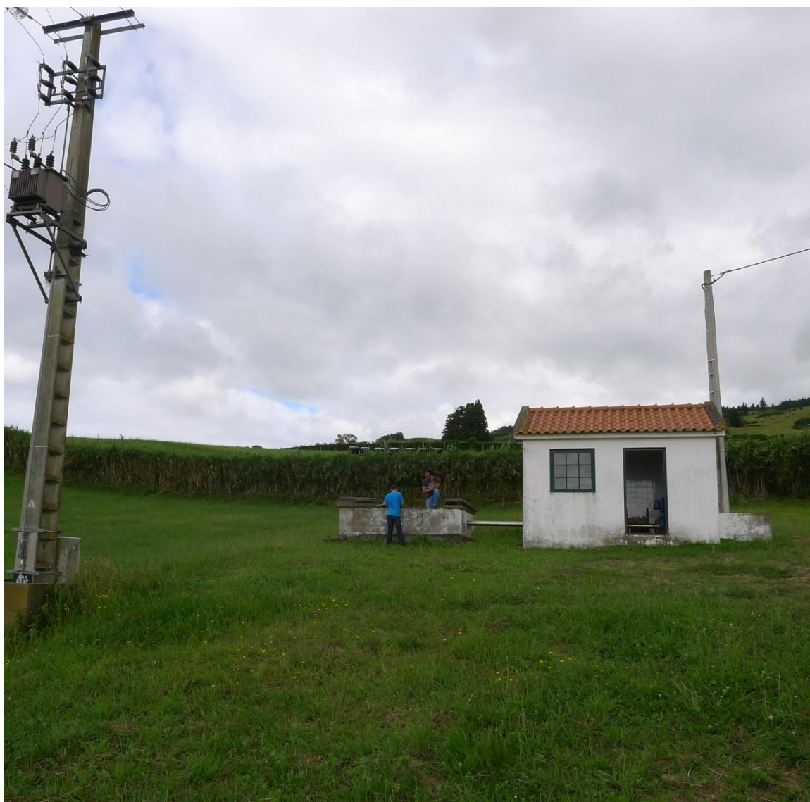
Vista geral do ponto de água.
