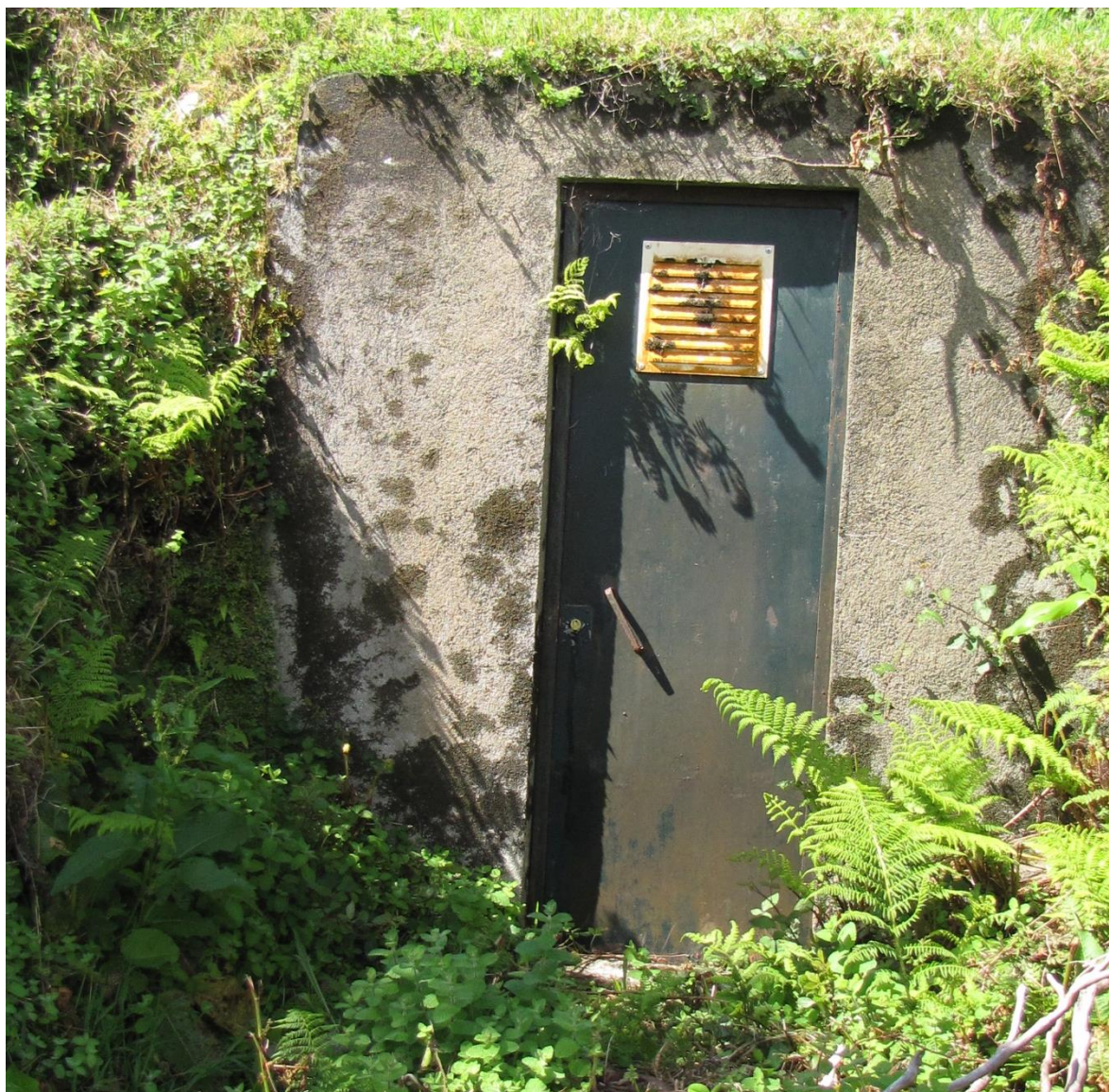
Vista geral do ponto de água.
