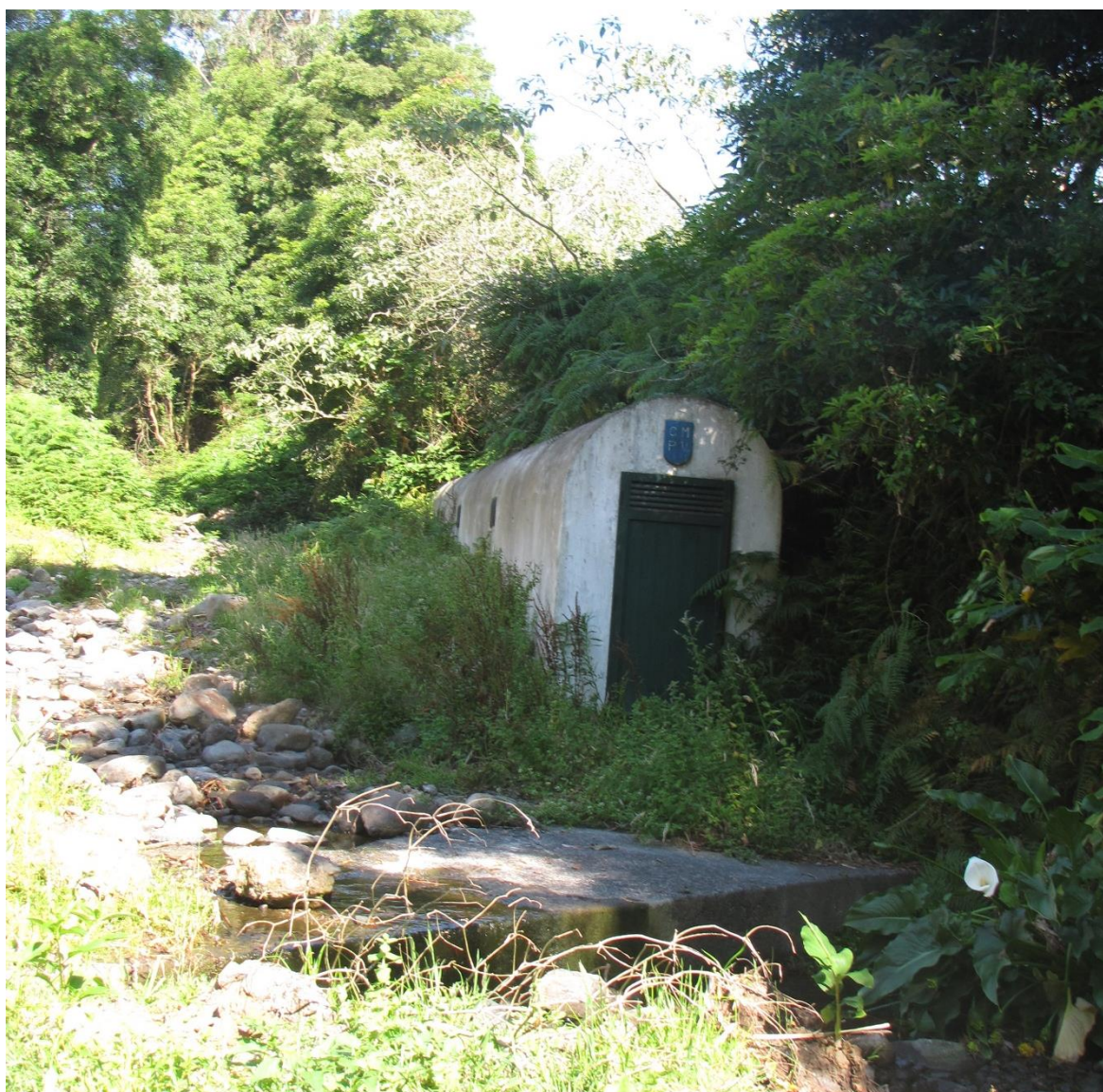
Vista geral do ponto de água.
