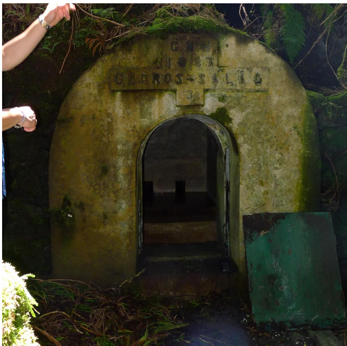
Vista geral do ponto de água.
