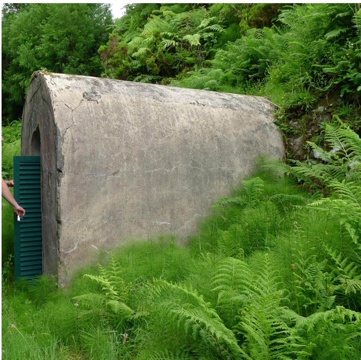
Vista geral do ponto de água.
