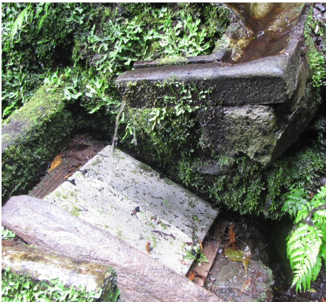
Pormenor do ponto de água.
