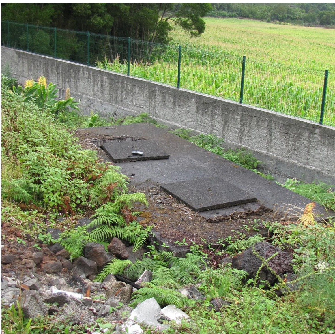
Vista geral do ponto de água.
