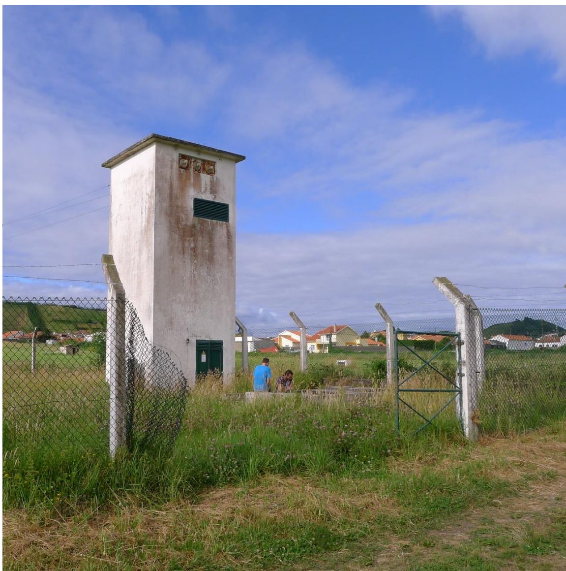
Vista geral do ponto de água.
