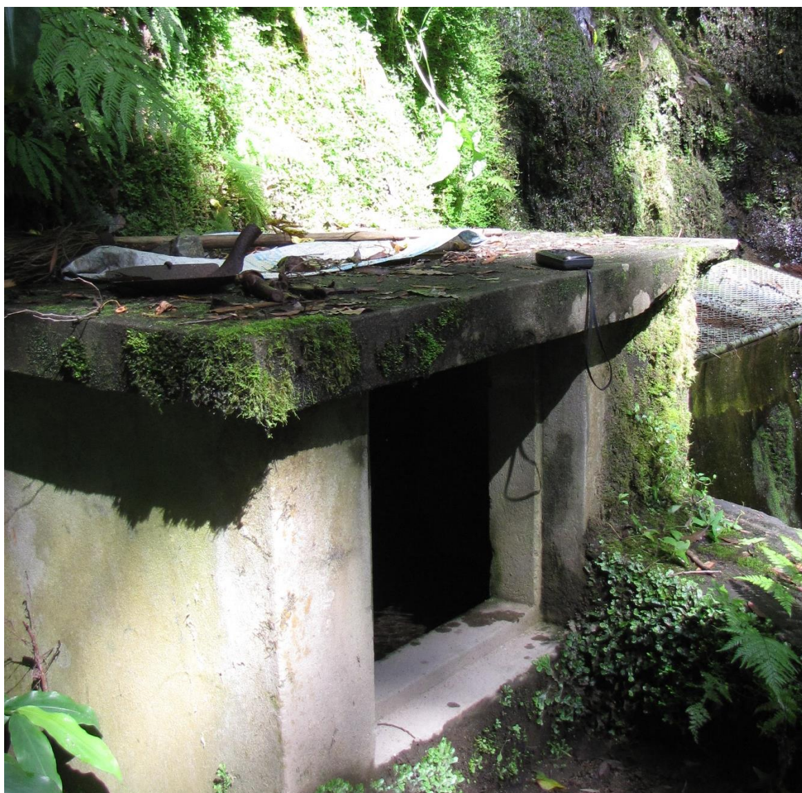
Vista geral do ponto de água.
