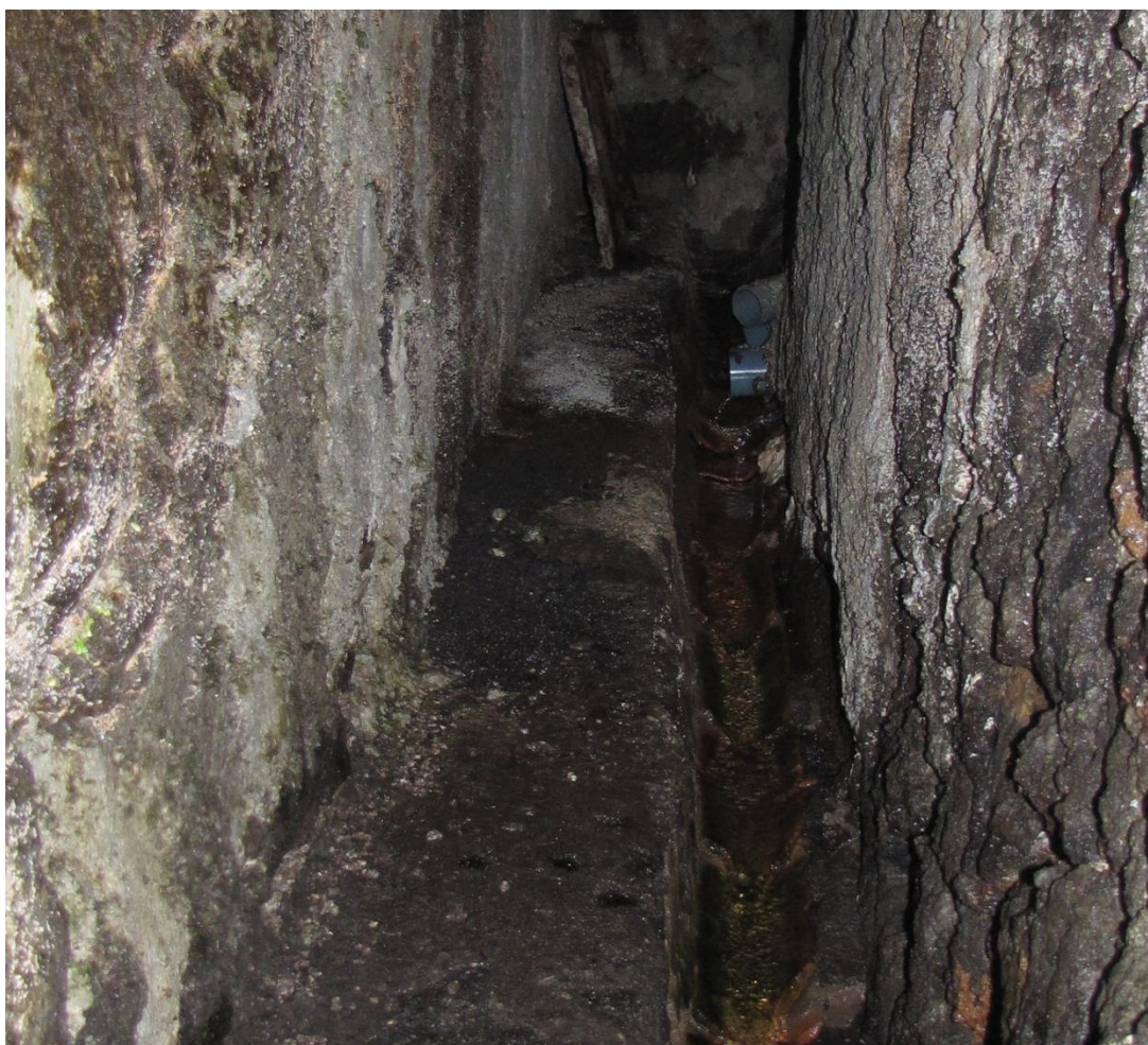
Pormenor do ponto de água.
