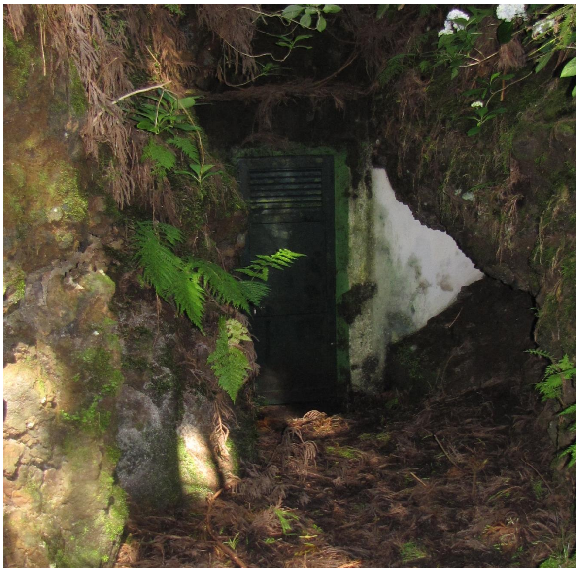
Vista geral do ponto de água.
