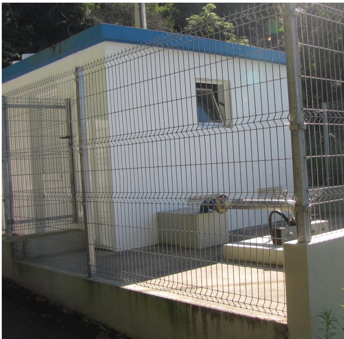
Vista geral do ponto de água.
