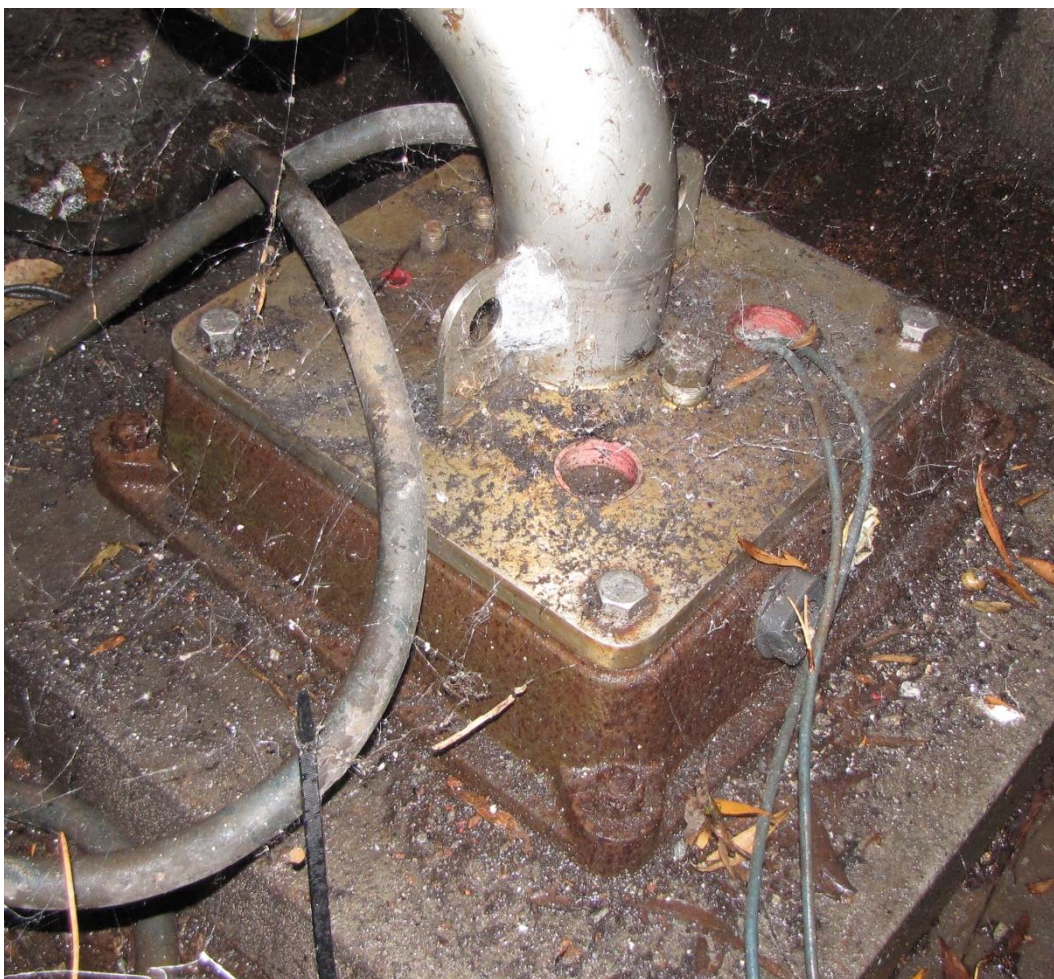
Pormenor do ponto de água.
