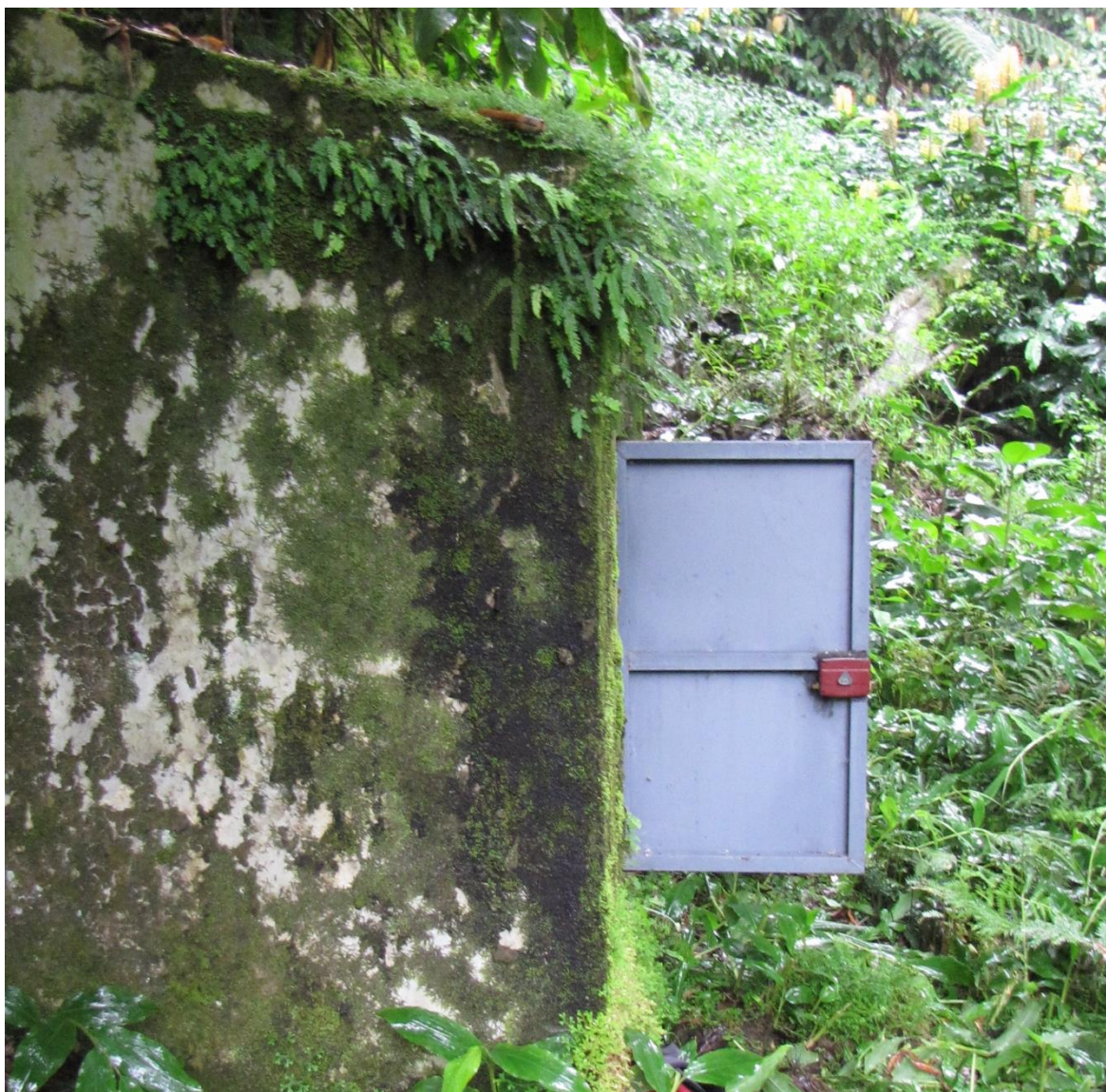
Vista geral do ponto de água.
