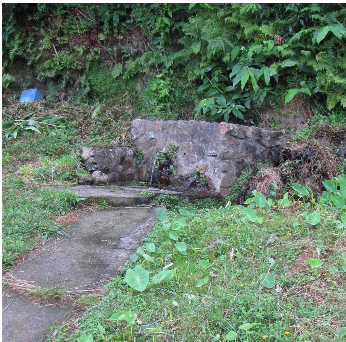
Vista geral do ponto de água.
