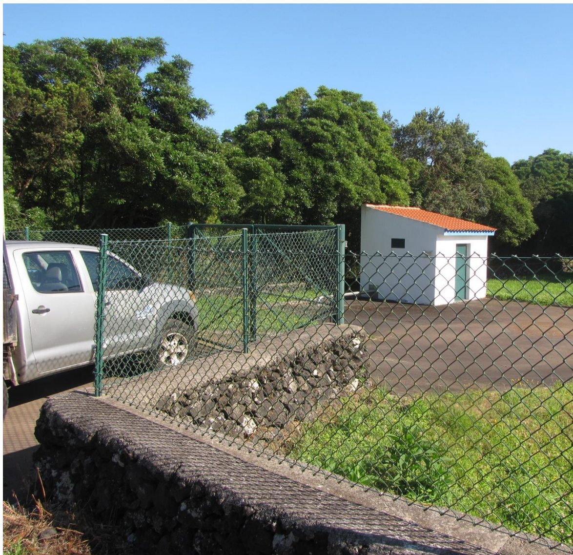
Vista geral do ponto de água.
