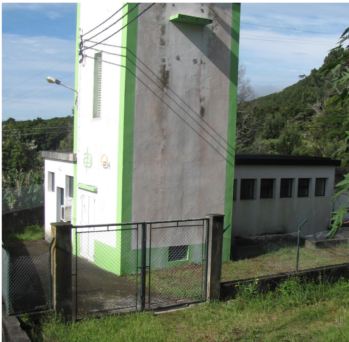
Vista geral do ponto de água.
