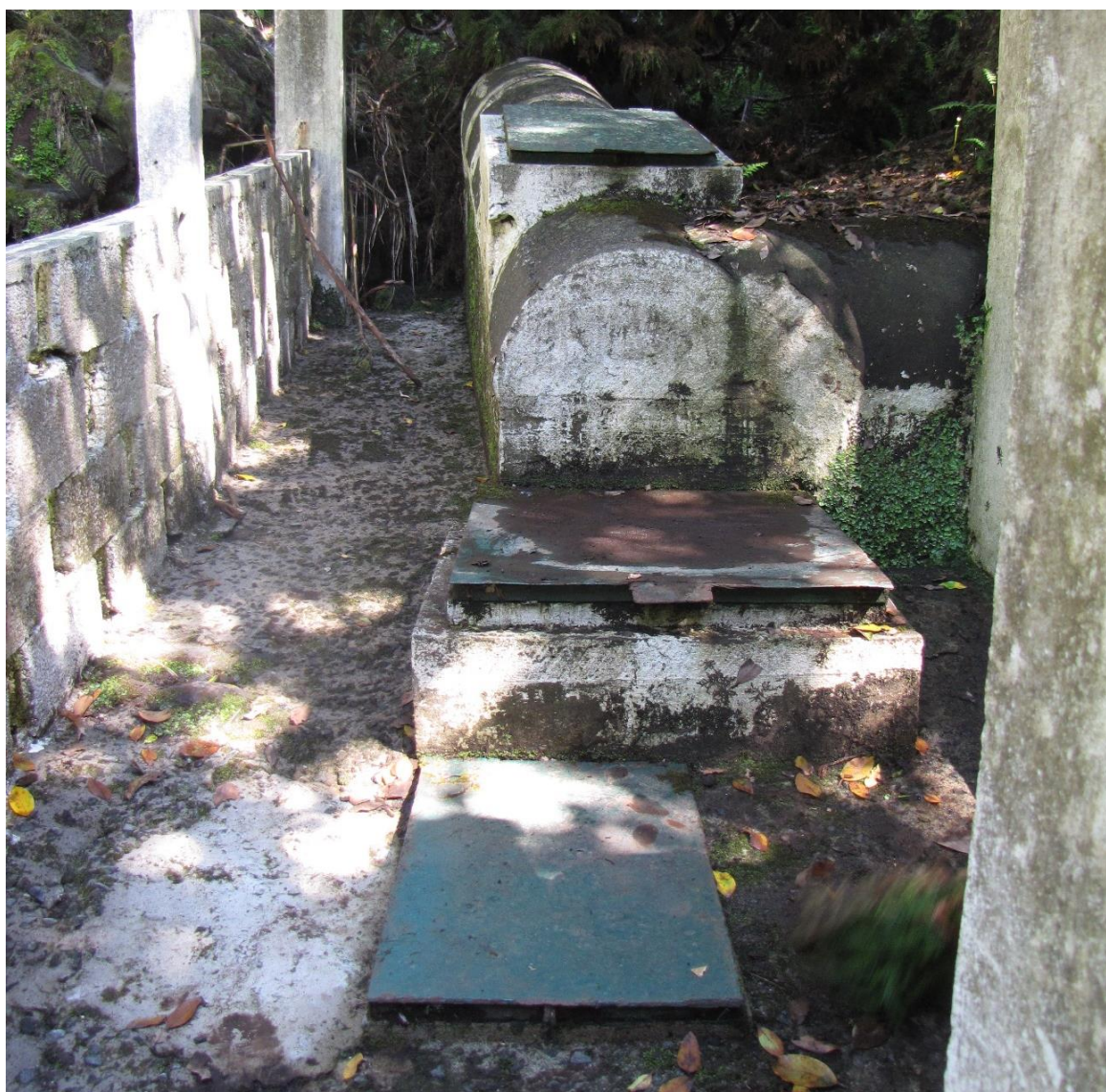
Vista geral do ponto de água.
