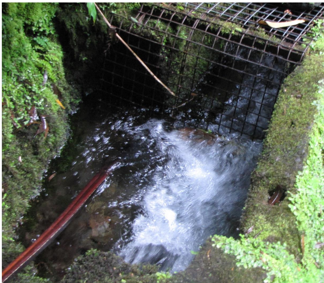
Pormenor do ponto de água.
