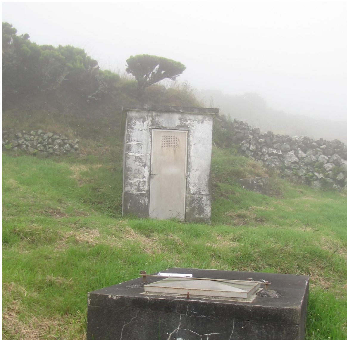
Vista geral do ponto de água.
