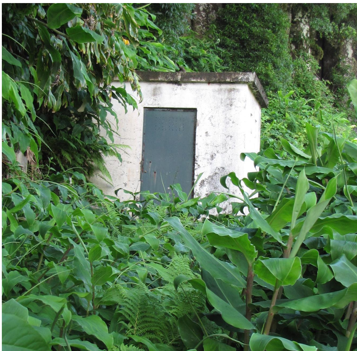
Vista geral do ponto de água.
