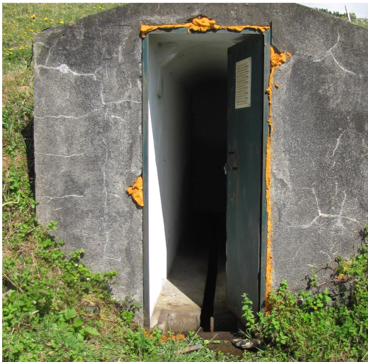
Vista geral do ponto de água.
