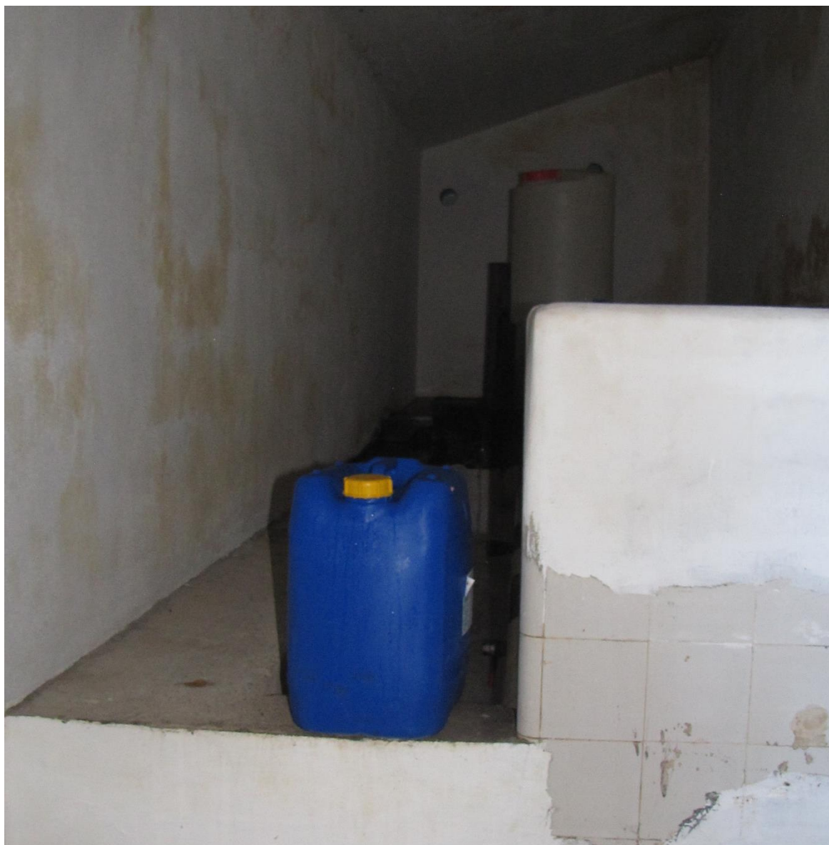
Vista geral do ponto de água.
