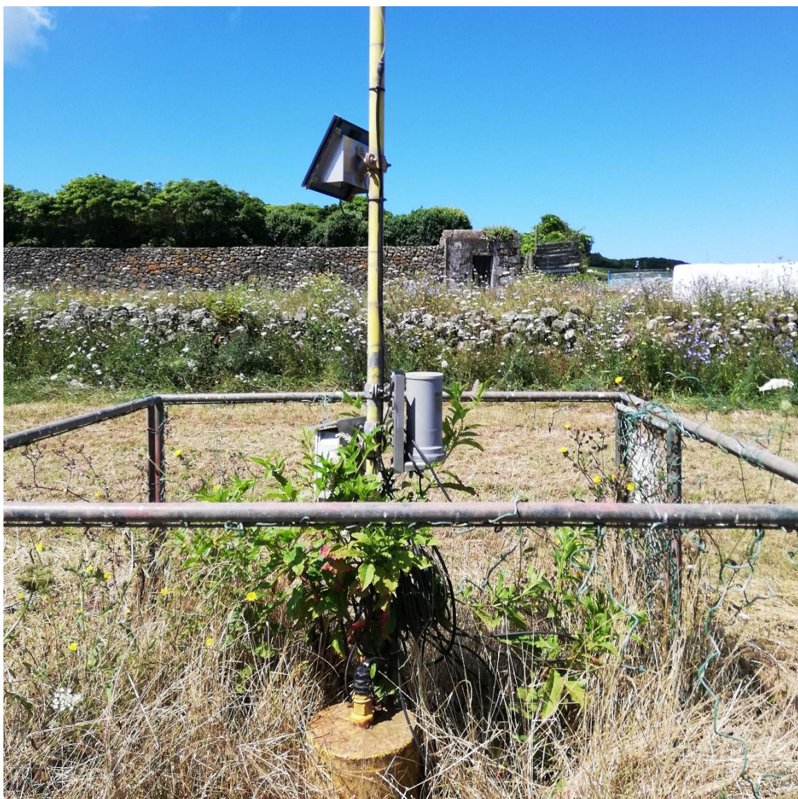
Vista geral do ponto de água.
