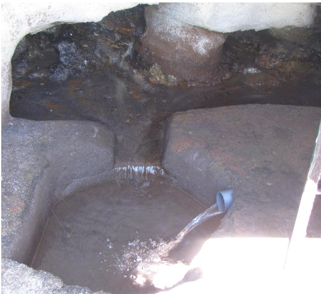
Pormenor do ponto de água.
