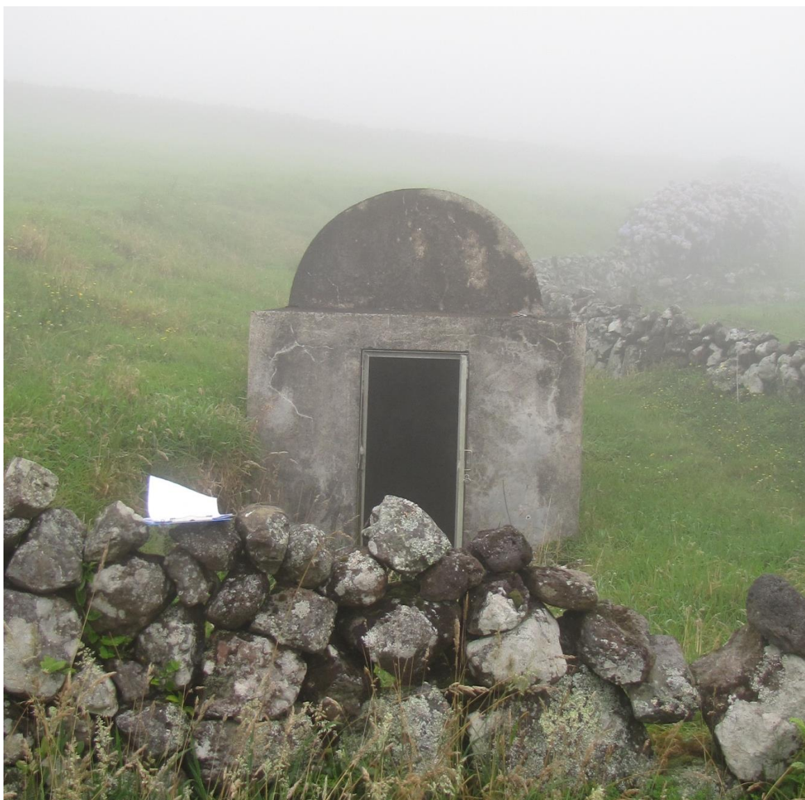
Vista geral do ponto de água.
