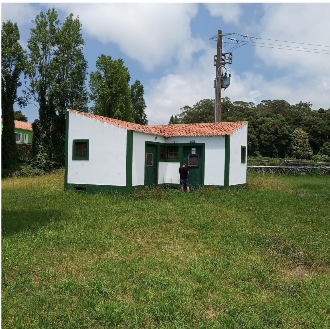
Vista geral do ponto de água.
