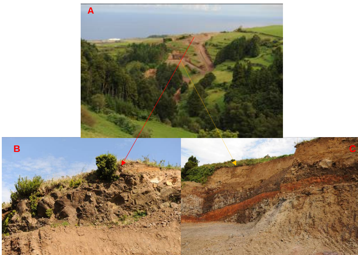
Fotografia 6 – (A) Vista geral do local onde se estão a realizar os trabalhos da nova estrada para o Nordeste; (B) Aspecto dos basaltos alterados onde se observa disjunção esferoidal e (C) Afloramento onde se observa uma sequência de escoadas lávicas alteradas cobertas por nível de solos relativamente espesso.
