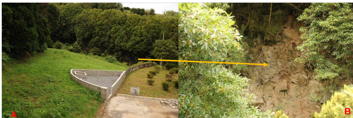
Fotografia 5 – (A) Aspecto da captação com a ribeira em 2º plano (B) pormenor do material aflorante na margem da ribeira, constituído essencialmente por basaltos s.l. muito alterados.
