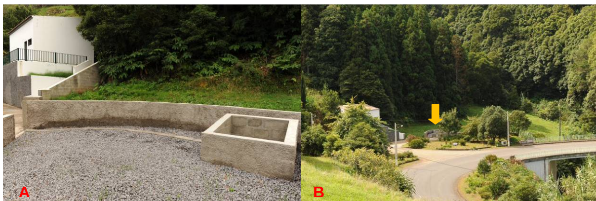
Fotografia 3 – Pormenores da captação (A) e (B) vistos do lado nascente.
