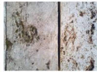
Pedra marès (calcarenita o eolianita) El marès es una piedra de las Islas Baleares, que se extrae en bloques
