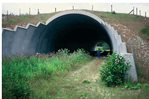
Figura Erro! Não existe nenhum texto com o estilo especificado no documento..24–Passagem inferior adaptada com corredor de vegetação herbácea (Fonte: Iuelle et al. , 2003).
