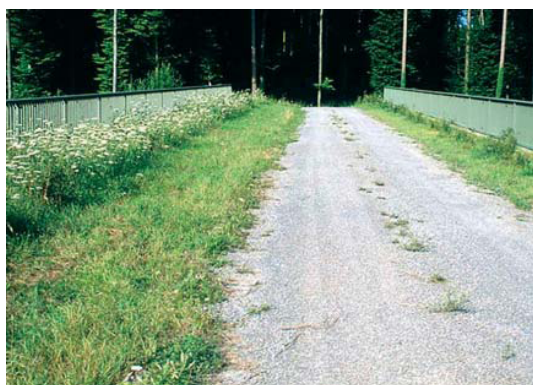
Figura Erro! Não existe nenhum texto com o estilo especificado no documento.. 22 – Passagem superior com faixas de vegetação laterais.
