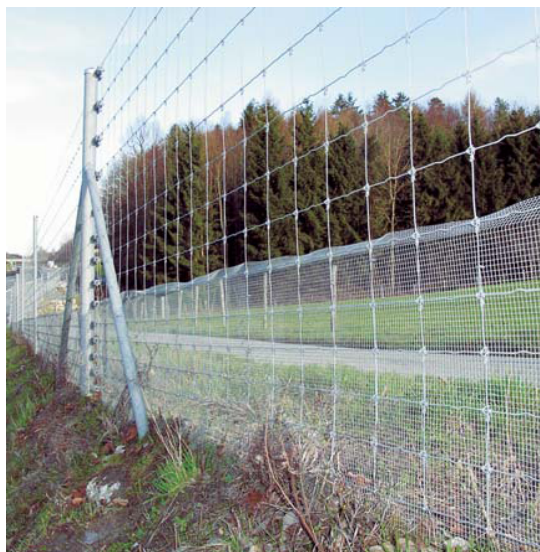
Figura Erro! Não existe nenhum texto com o estilo especificado no documento..19 - Representação de uma vedação com malha progressiva (Fonte: Ministerio de Medio Ambiente, 2006).
