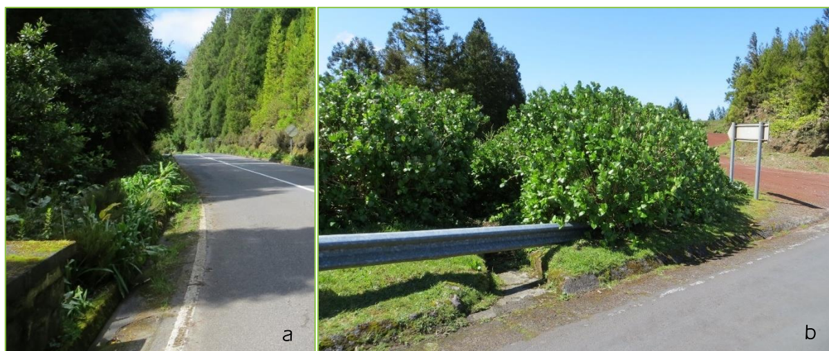
Figura 3.19 | Valeta no troço da E.R. 9-2ª (Ponta Delgada) (a) e valeta e ponto de saída de água junto ao parque de estacionamento de longa duração (b)
