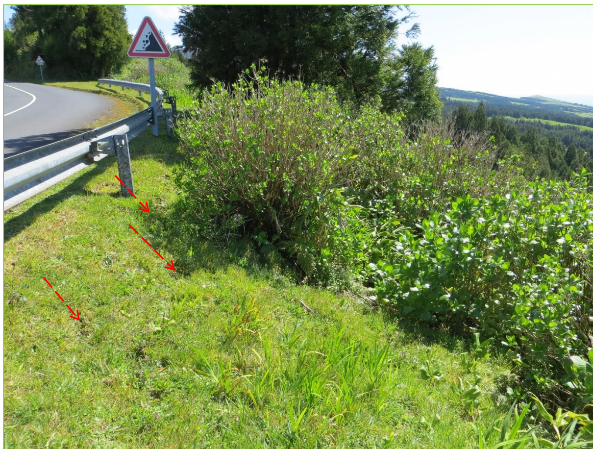
Figura 3.16 | Sinalização de perigo de queda de pedras no troço da E.R. 8-2ª, no sentido Covoada, e evidências de instabilidade geomorfológica na zona adjacente à mesma estrada. Março de 2021.
