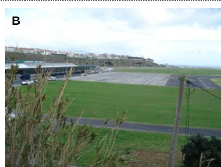
Zona de ampliação da plataforma W
