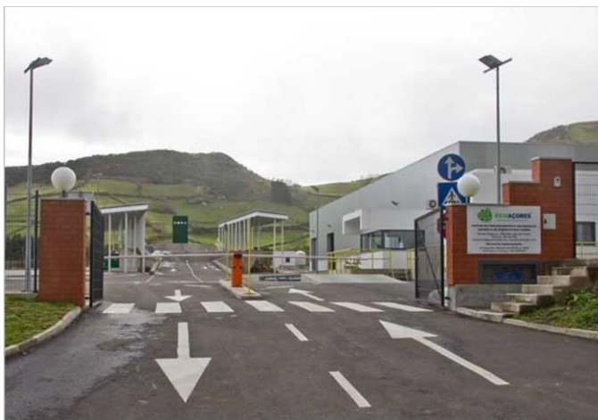
Figura 1 – Centro de Processamento de Resíduos das Flores
