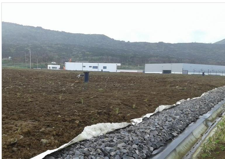
**Figura 1 – Selagem do aterro e instalações do CPR na ilha do Faial**
