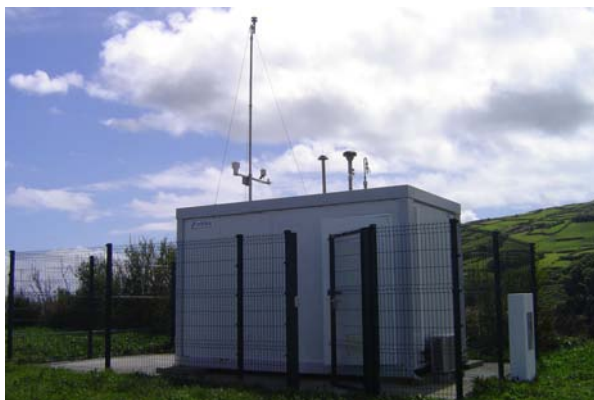
Estação de monitorização de qualidade do ar dos Espalhafatos (Faial)
