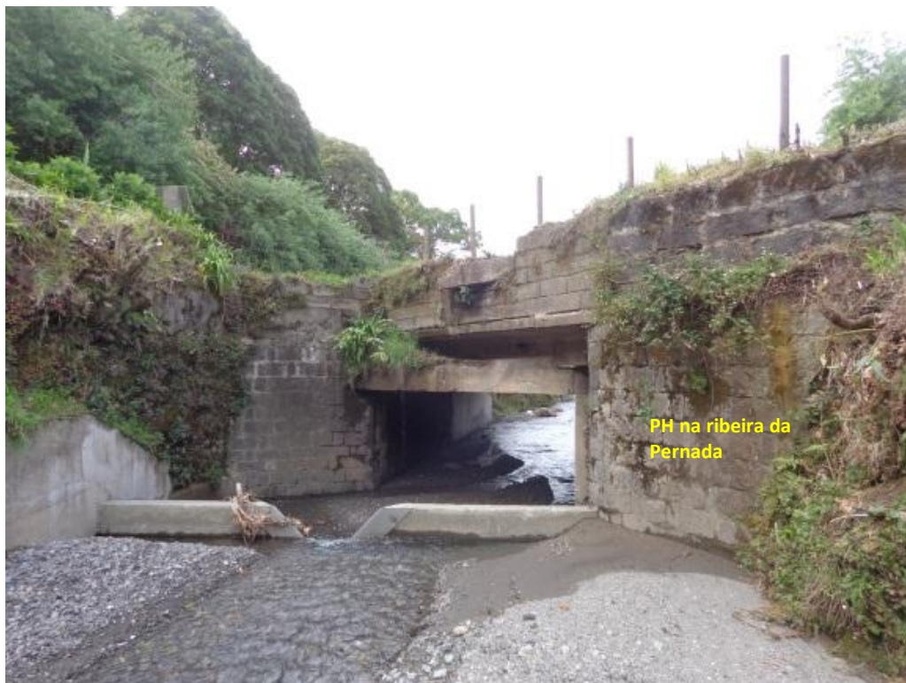
Figura 3.3 – Passagem hidráulica existente na ribeira da Pernada
