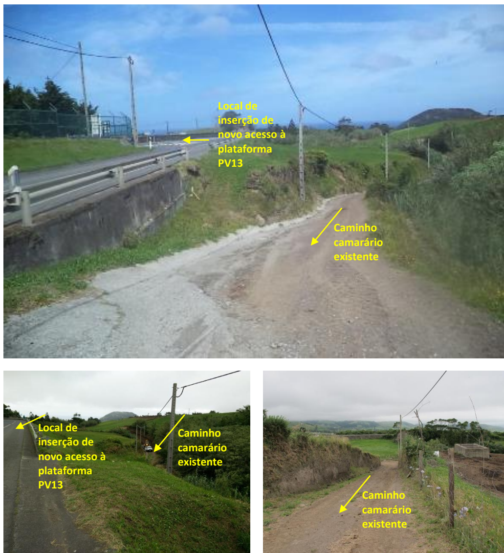
Figura 3.6 – Estrada Regional E.R-5-2ª no local onde se pretende a ligação do novo acesso à plataforma PV13 e caminho camarário existente
