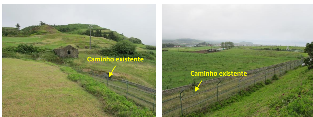
Figura 3.10 – Local de implantação da plataforma do poço geotérmico PV14
