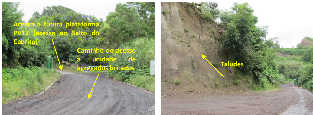
Figura 3.2 – Acesso à futura plataforma do poço geotérmico PV12 - situação existente
