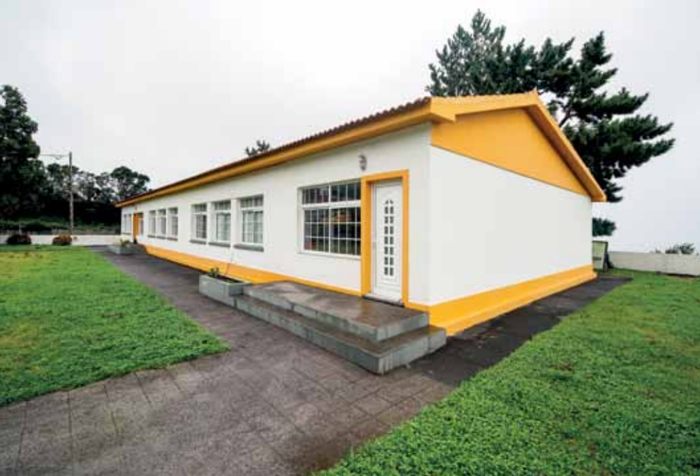
Figure 111. Fajã da Caldeira de Santo Cristo Interpretation Centre
