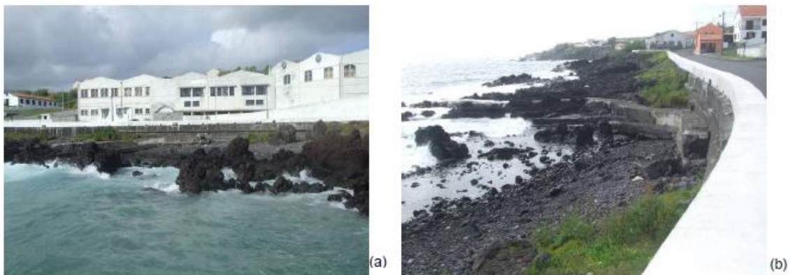
Fonte: Equipa Técnica. (a) Vista da Fábrica da Cofaco; (b) Pomenor do esgoto.
