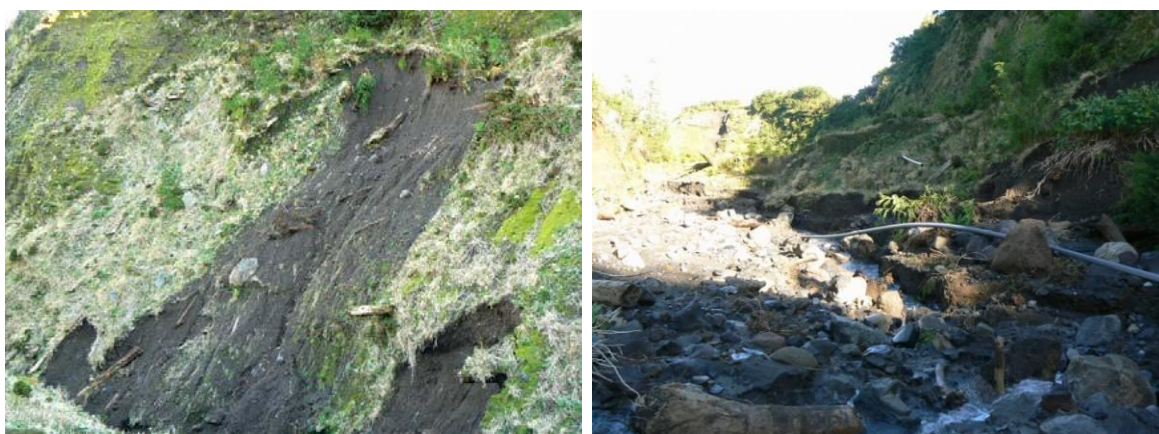
Figura 2.9.39 | Destruição de uma captação de água no decurso do desenvolvimento da escoada detritica que se desenvolveu durante a ocorrência do sismo de maior magnitude do dia 9 de julho de 1998.
