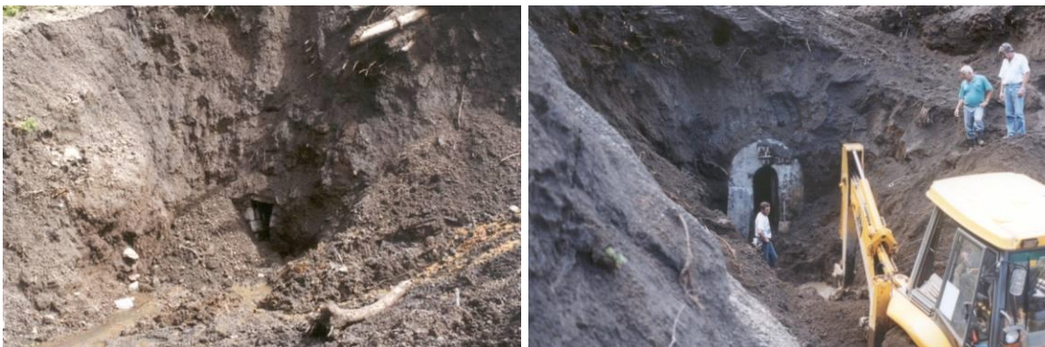
Figura 2.9.39 | Destruição de uma captação de água no decurso do desenvolvimento da escoada detritica que se desenvolveu durante a ocorrência do sismo de maior magnitude do dia 9 de julho de 1998.
