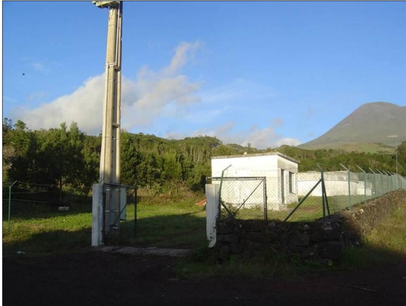
Figura 2.9.35 | Furo para abastecimento inserido em área relativamente plana.
