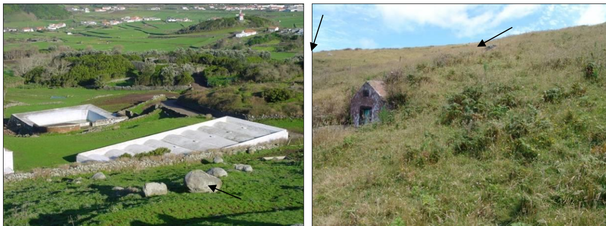
Figura 2.9.23 | Presença de blocos rochosos de grandes dimensões, que poderão afetar os reservatórios e nascentes da Serra das Fontes. As setas indicam a presença de blocos rochosos a montante de reservatórios e de uma nascente.
