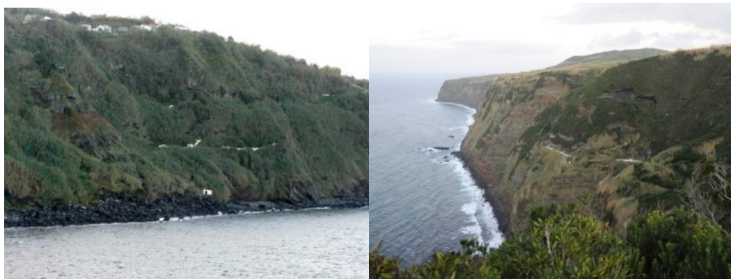
Figura 2.9.57 | (a) Vista da costa de Santo António e da captação com o mesmo nome e b) vista da costa dos Mosteiros e das captações dos Moinhos e da Figueira.
