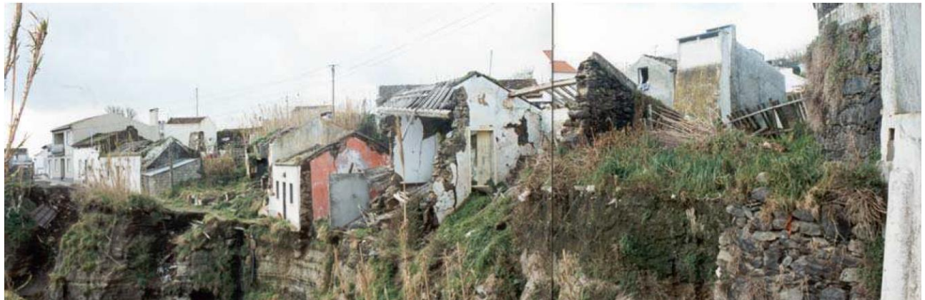
Figura 2.9.63 | Rocha dos Campos: estrada parcialmente destruída e casas desmoronadas como consequência do recuo da arriba.
