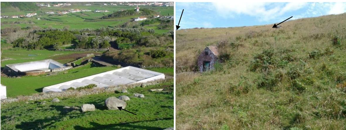
**Figura 2.9.26** | Presença de blocos rochosos de grandes dimensões, que poderão afetar os reservatórios e nascentes da Serra das Fontes. As setas indicam a presença de blocos rochosos a montante de reservatórios e de uma nascente.
